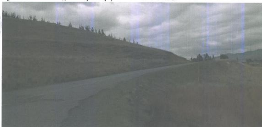
Foto N° 39 y 40. Cortes típicos a media ladera de pendiente moderada a fuerte con alturas de corte menores a 5 m de altura, la imagen corresponde al km 38+870, sobre depósitos residuales producto de la meteorización de rocas intrusivas.
