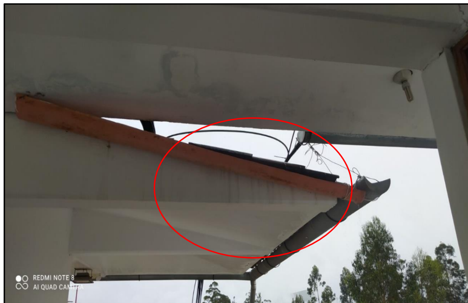
Imagen 04. Se puede evidenciar que no existe continuidad entre canaletas. Además, la canaleta está siendo sujeta por cable eléctrico.
