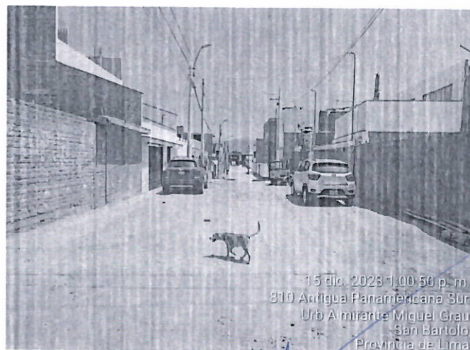
FOTO 08.- Se puede apreciar pavimento a nivel de afirmado
