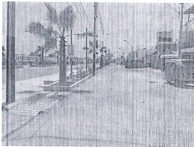
FOTO 21.- Se puede apreciar pavimento a nivel de afirmado, vía auxiliar de la Av. San Bartolo.
