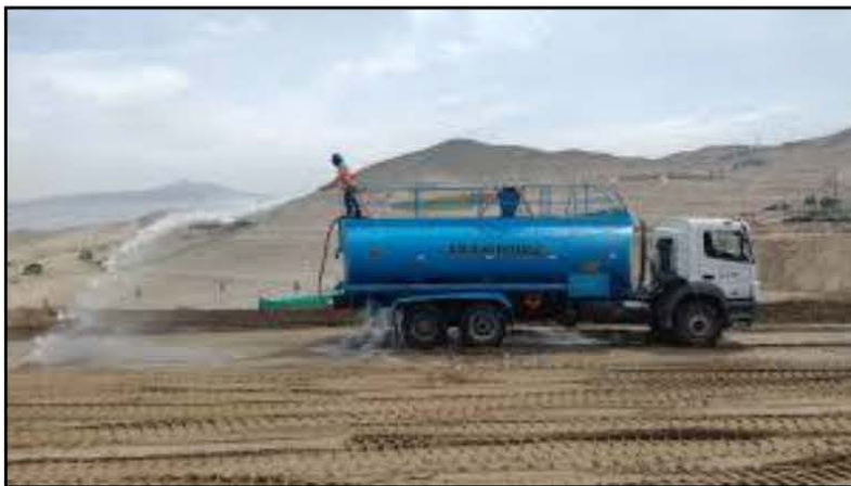
Figura N° 03 REGADO DE TERRENO
