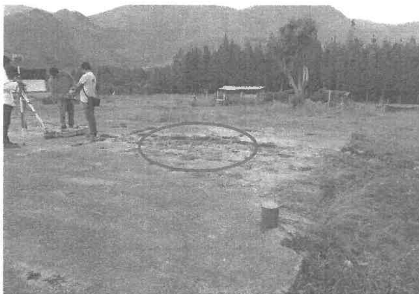
Se observa el hundimiento de la losa
