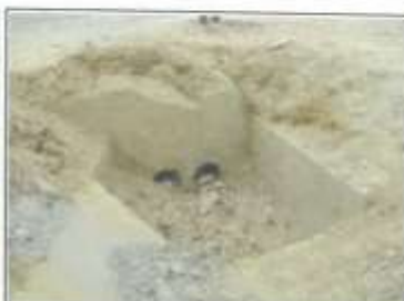
Foto 04: Ingreso de alcantarilla de desfogue en inicio de tramo, dos tuberías Ø 3' cada una. Cabezal de ingreso en malas condiciones y obstruido.
