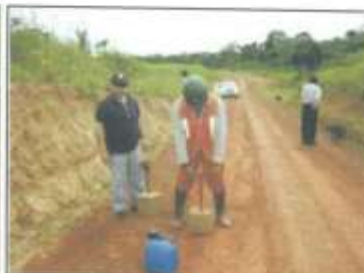
Foto 02: Compactación de Raches (Rachos), en un Mantenimiento Rutinario
