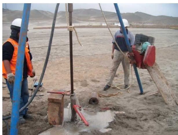
Figura 5 Aplicación de lavado con wash boring
