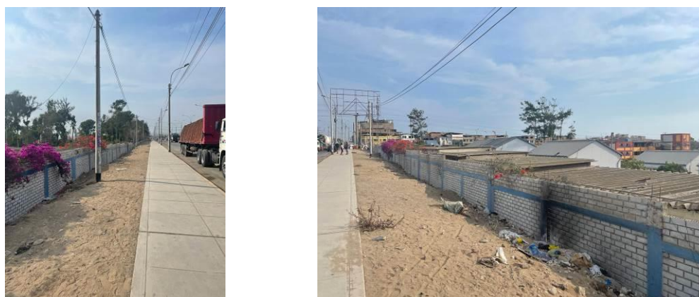
Figura 14 Relleno de material suelto empujando muro de cerco péimétrico
