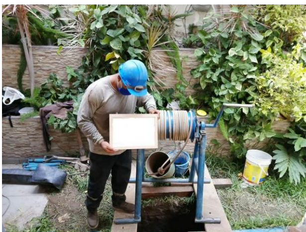
Figura 7 Excavación de calicata manual con malacate
