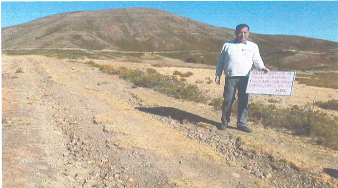
Foto N°2: Zonas con alto deterioro por erosión
