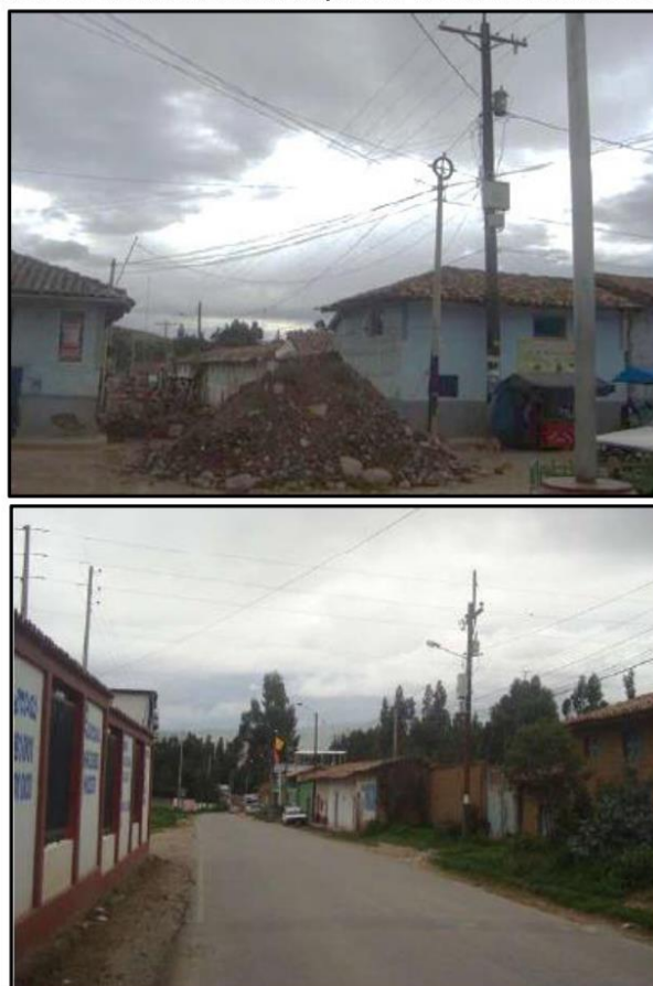
Fig. N° 05: Redes de media tensión incumpliendo distancias mínimas de seguridad
