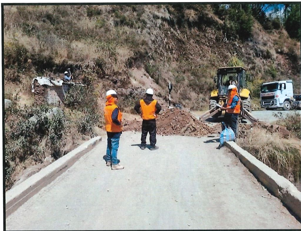
Fig. 03: Vista del puente existente tipo losa, con plataforma desgastado y en mal estado
