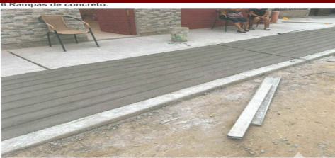
Imagen N° 09: Vaciado de Concreto en rampas
