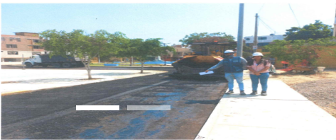
IMAGEN N°10: Se realiza la colocacion de asfalto caliente con polimeros
