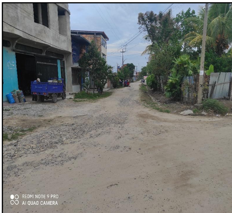
Jr. Atahualpa C-01 El sistema de drenaje es deficiente y no cumple con la función correctamente.
