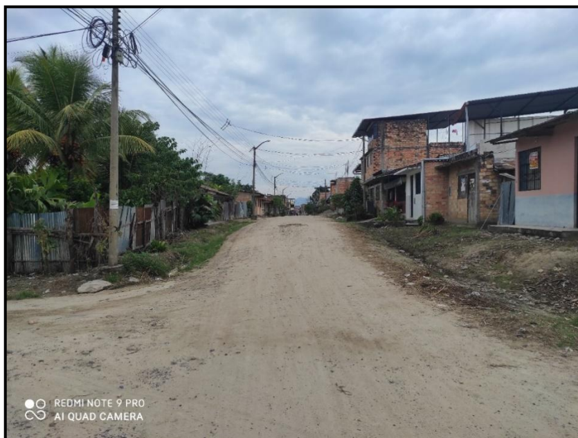
Jr. Bolognesi C 13 – Se aprecia el estado en deterioro en la que se encuentra la vía correspondiente, y también se puede observar la carencia de un drenaje pluvial.
