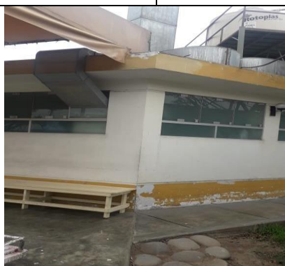
Foto N°05: Se observa toldo que se fija en la columna de la edificación que tendrá que retirarse para la instalación de las columnas metálicas y luego volverá a colocarlas.
