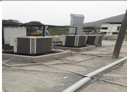
Foto N° 02: Se observa equipos de aire acondicionado expuestos a la interperie, instalaciones eléctricas y sanitarias en el piso del techo.
