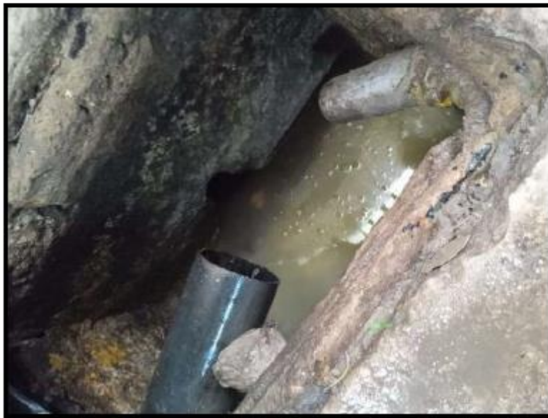
Imagen N° 3: Se observa una caja registro colmatada, se plantea descolmar, limpiar y desinfectar.
