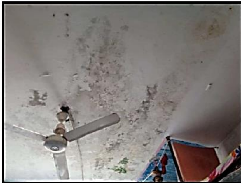
Imagen N° 12: Se observa presencia de marcas de filtración, se plantea la reparación de las tuberías ya sea de agua o desagüe.
