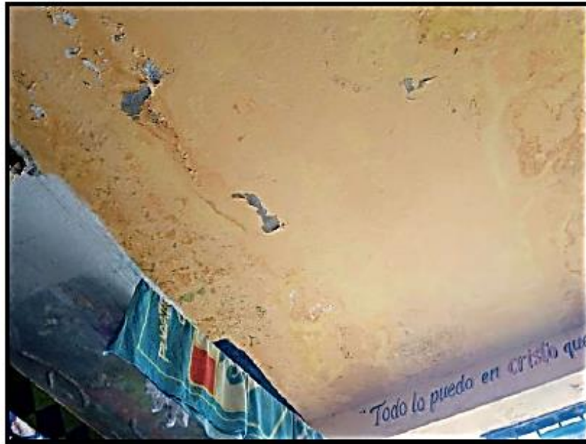
Imagen N° 11: Se observa presencia de marcas de filtración, se plantea la reparación de las tuberías ya sea de agua o desagüe.
