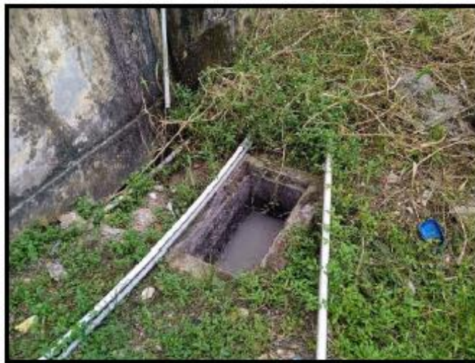
Imagen N° 4: Se observa una caja registro colmatada, se plantea descolmar, limpiar y desinfectar.
