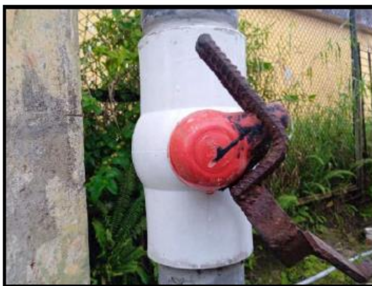
Imagen N° 8: Se observa una válvula esférica de 3" en mal estado, se plantea su reemplazo por una de bronce.
