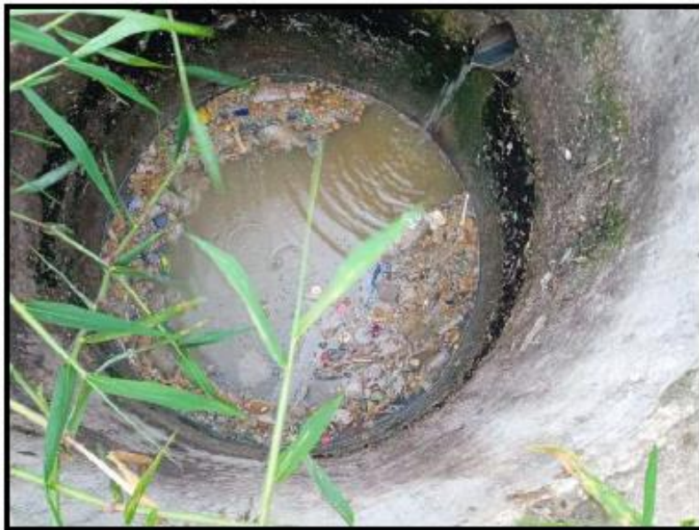
Imagen N° 7: Se observa presencia de acumulación y colmatación de aguas negras dentro del buzón, se plantea limpieza, descolmatación y desinfección.
