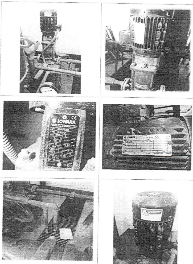
Fotografías de la Bomba secundaria "JOCKEY" No Listada, certificada y normada, se visualiza sellos, empaques resacos y presencia de polvo y óxidos, y muros de apoyo de bomba con presencia de eflorescencia.
