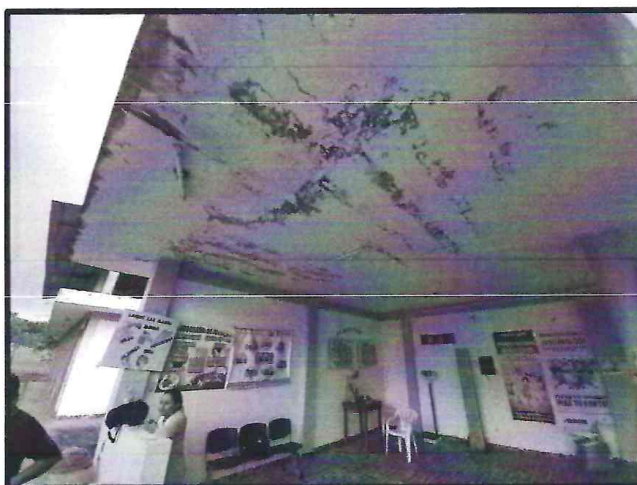
FOTO 04 – (16-03-2023) Se observa en la imagen el cielorraso en pésimo estado debido a las filtraciones de agua de lluvia por la mala colocación de contrapiso en la parte superior del techo de concreto.
