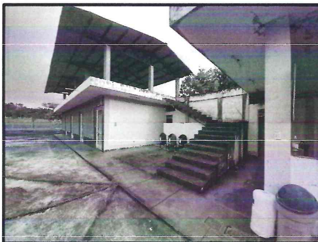
FOTO 02 – (16-03-2023) Se observa en la imagen otra perspectiva de la fachada principal del establecimiento de salud en donde se aprecia el techo en mal estado y la falta de canaletas, así como la pintura deteriorada
