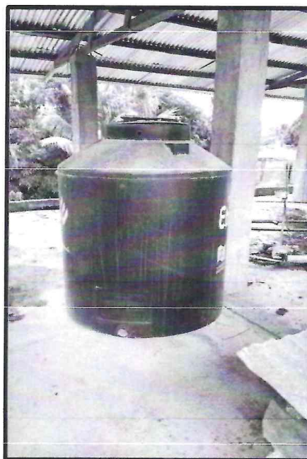
FOTO 09 – (16-03-2023) Se observa en la imagen el tanque de 1100 lt sin conexión además de estar en malas condiciones.
