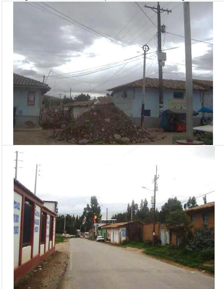
Fig. 4. Redes de media tensión incumplimiento distancias mínimas de seguridad
