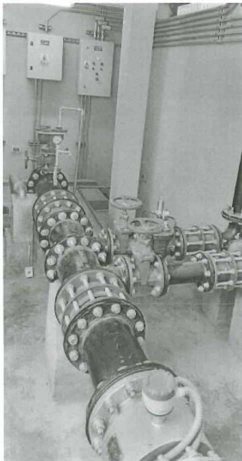
IMAGEN 1: ÁRBOL HIDRÁULICO DE POZO TUBULAR
