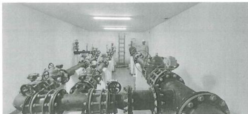
IMAGEN 10: ÁRBOL HIDRÁULICO CÁMARA DE SECTORIZACIÓN
