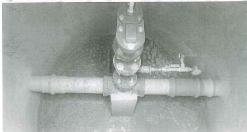
IMAGEN 12: VÁLVULAS DE AIRE
