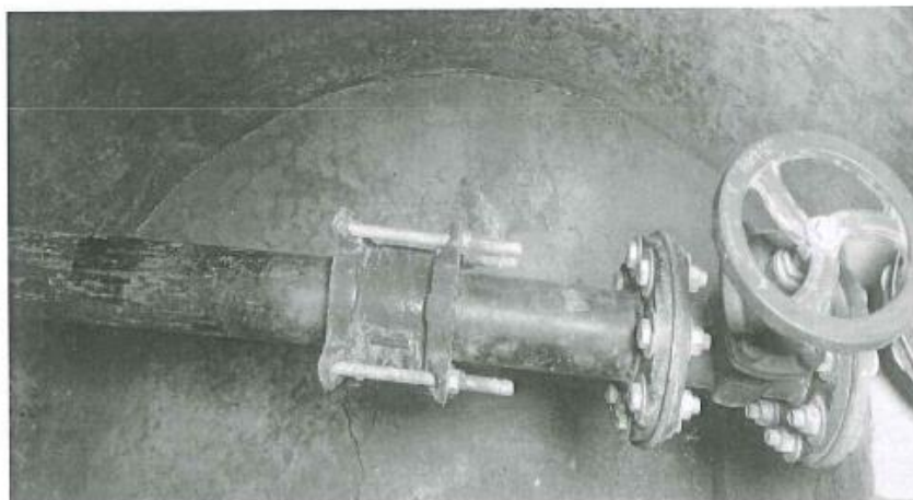
IMAGEN 13: VÁLVULAS DE PURGA
