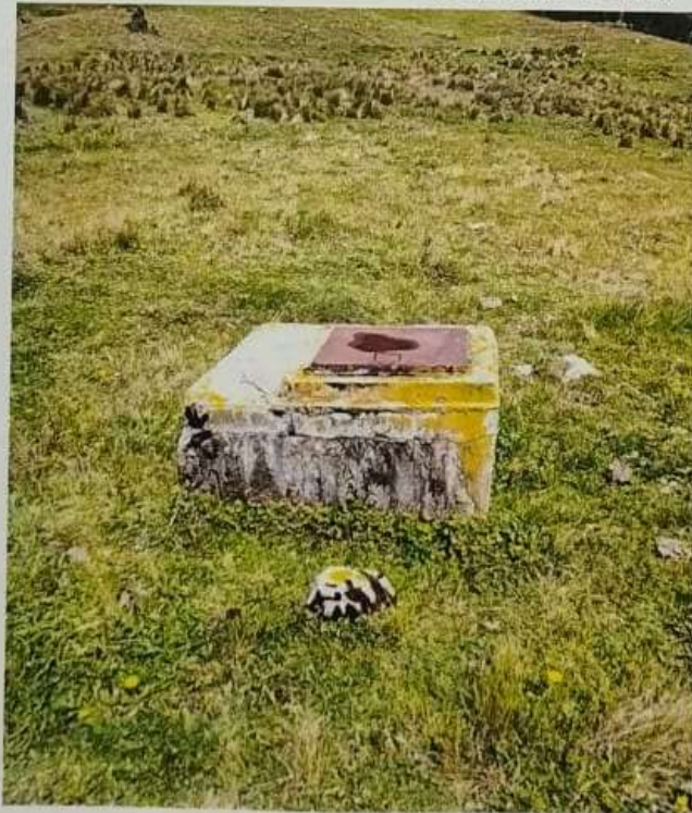
Fotografía N 2. Captación de Manantial, superado su tiempo de servicio.
