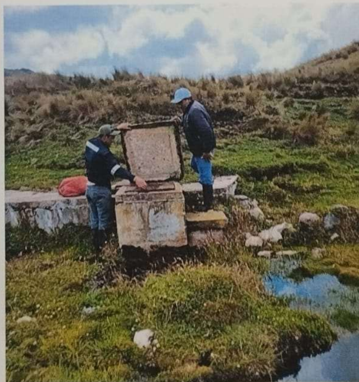
Fotografía N 2. Captación de Manantial, superado su tiempo de servicio.
