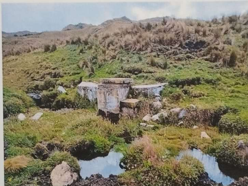
Fotografía N 3. Captación de Manantial fuera del tiempo de servicio.
