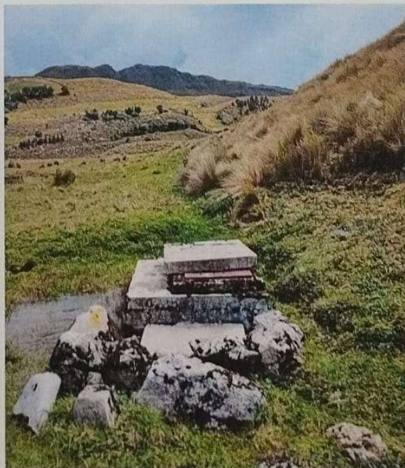
Fotografía N 4. Captación de Manantial fuera del tiempo de servicio.
