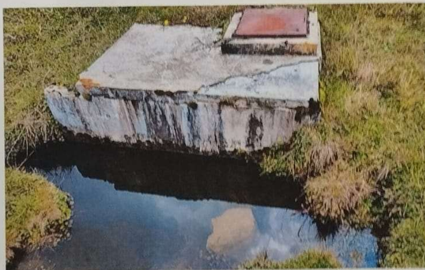
Fotografía N 2. Captación de Manantial, superado su tiempo de servicio.
