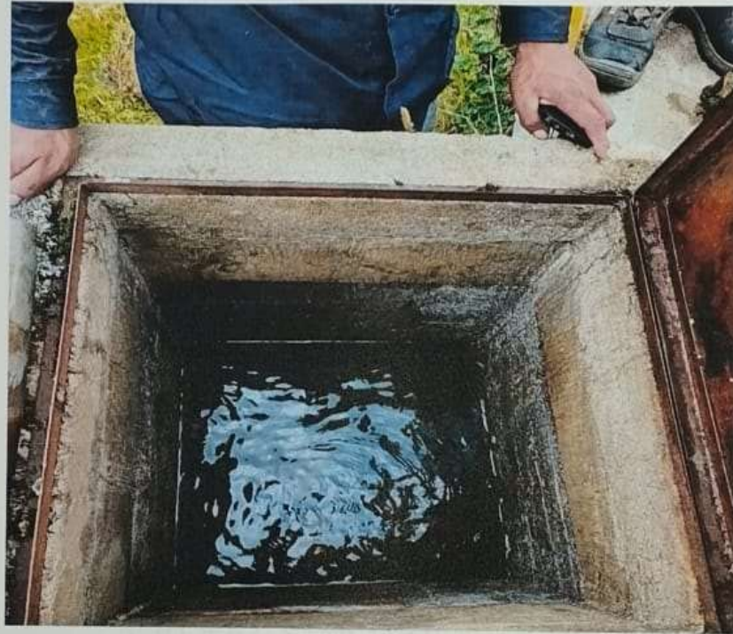
Fotografía N 3. Captación de Manantial fuera del tiempo de servicio.
