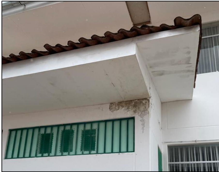
Imagen 03. Humedad en elementos de concreto.
