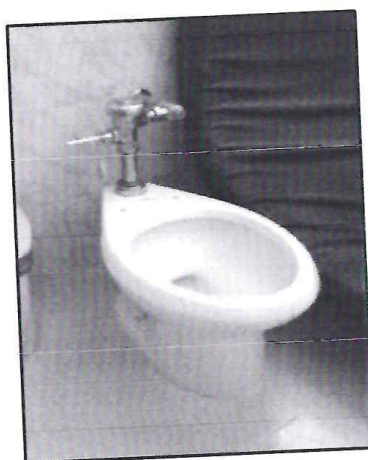
FOTO N°06 - 12/09/2023: Se verifica el mal funcionamiento de Fluxómetro en inodoros de diversas áreas.
