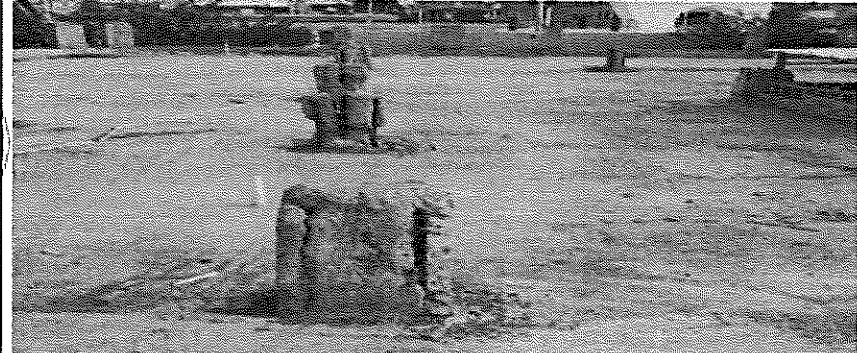
PEDESTALES DE CONCRETO SOBRE LOSA CON ACEROS CORROÍDOS
