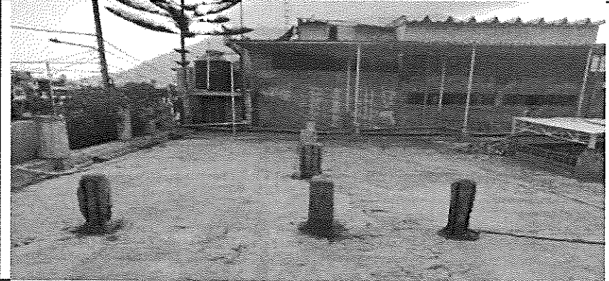
PEDESTALES DE CONCRETO SOBRE LOSA CON ACEROS CORROÍDOS
