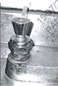
Grifería con corrosión.
