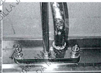
Grifería deteriorada y sin manija.
