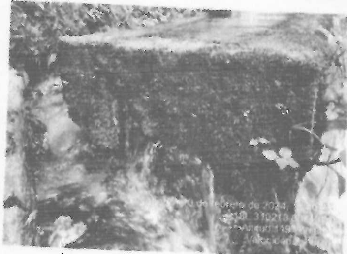
IMAGEN 8: Grieta en la estructura, por la cual se genera la filtración del agua
