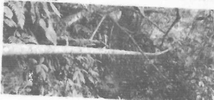
IMAGEN 12: línea de conducción pasa por roca firme, lo cual ha impedido enterrar la tubería
