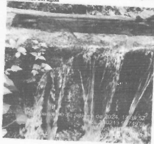
IMAGEN 7: Agrietamientos del concreto, esto debido a la antigüedad de la estructura la fuerza del agua
