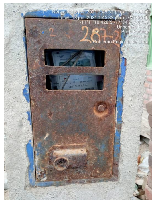
Acometidas en mal estado.
