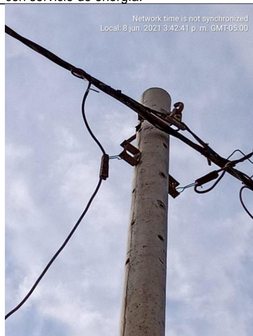
Acometidas conectadas a la red, sin conector correspondiente
