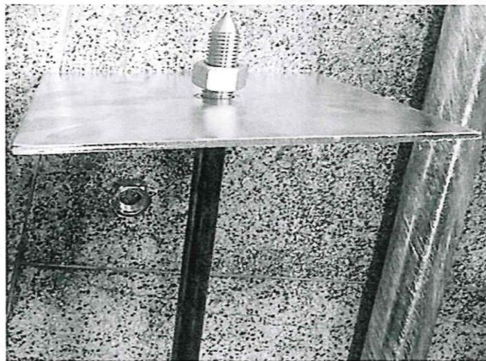
**3.3.4. CONECTOR DE COBRE TIPO ANDERSON DE 3/4 in PARA PUESTA A TIERRA**
