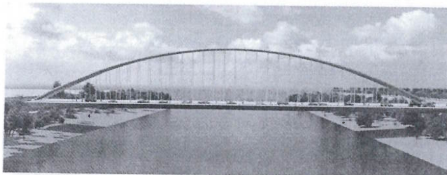
Gráfico 3. Elevación de Alternativa de puente tipo arco
