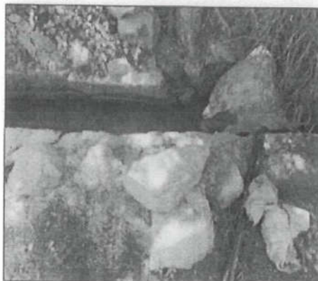
FOTO N° 04: Tubería HDPE en mal estado.
