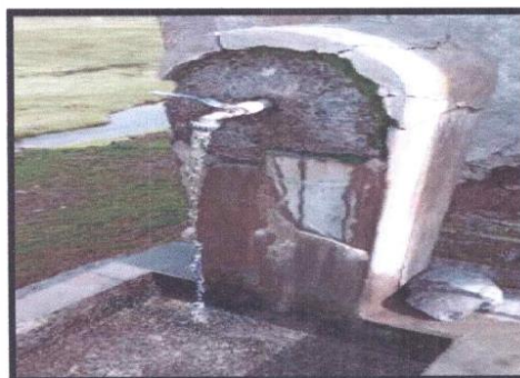
FOTOGRAFÍA N° 15 RESANE CON MORTERO EN PILETA
