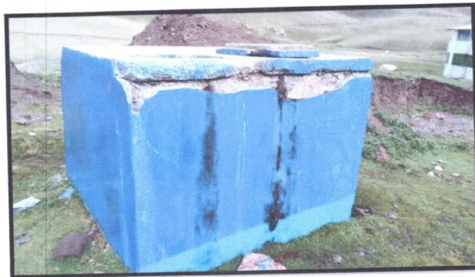
FOTOGRAFÍA N° 14 RESANE CON MORTERO EN RESERVORIO
