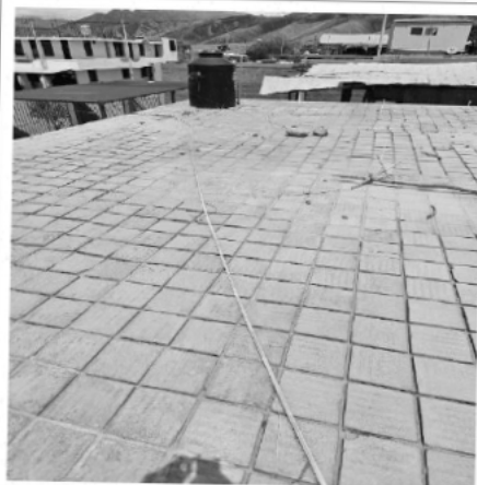
El techo aligerado se encuentra en mal estado por la filtración de la humedad
