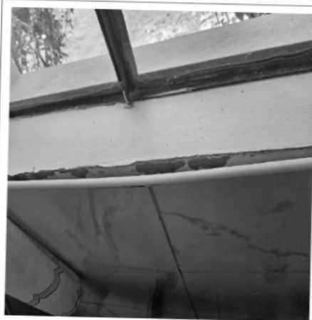
Zócalos y piso en mal estado, requieren sustitución de cerámico
