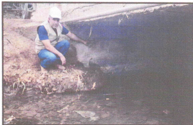
Foto N° 02: estribos de apoyo presentan fisuras y grietas.
