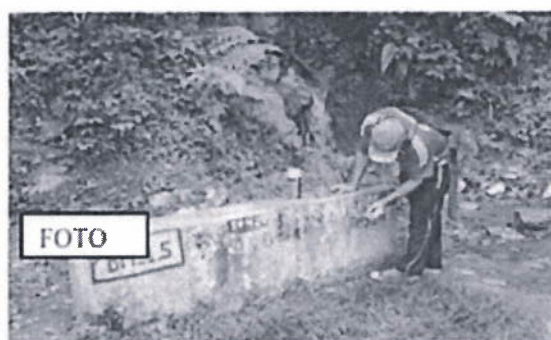
FOTO N° 02: En la imagen se aprecia colocación y pintado de Pis, para el apoyo de la poligonal.
