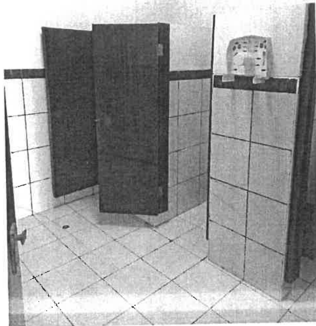
Fotografía 14. Demolición de muros divisorios de ladrillo e instalación de divisiones y puertas de melamina en el tercer nivel de los servicios higiénicos del Block "D".
