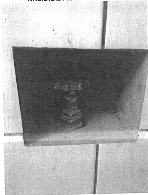
Fotografía 9. Cambio de válvulas compuertas antiguas y construcción de nichos en los 03 niveles de servicios higiénicos del Block "D".
