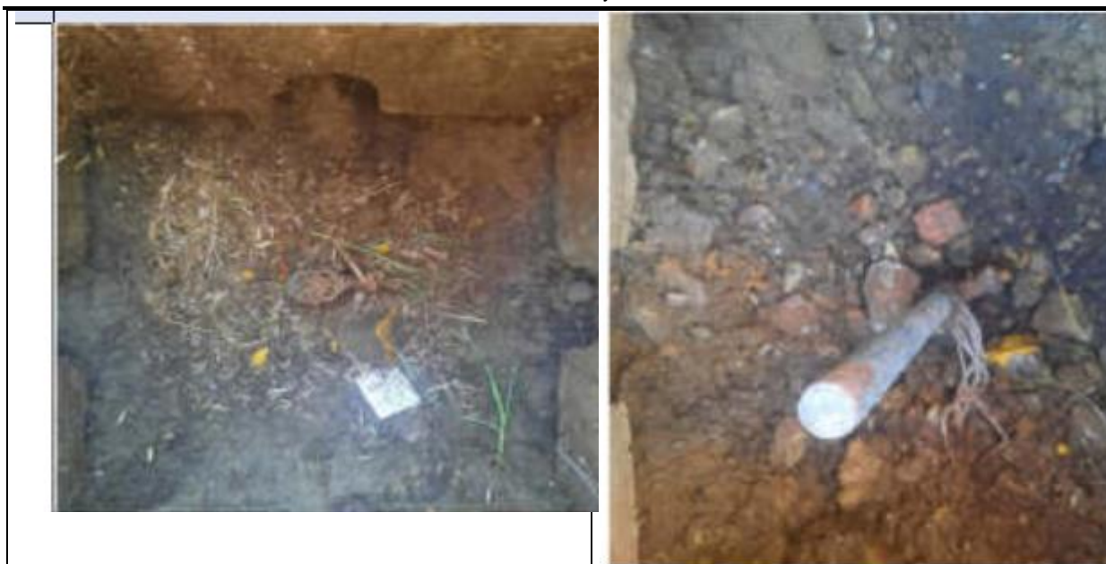
Fig. N° 38 POZOS UBICADOS ALREDEDOR DEL TAMBO, PARA CAMBIO DE CONECTOR, TAPA Y LIMPIEZA
