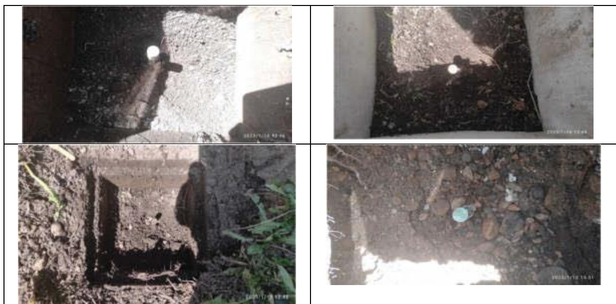
Fig. N° 12 POZOS UBICADOS ALREDEDOR DEL TAMBO, PARA CAMBIO DE CONECTOR, TAPA Y LIMPIEZA.
