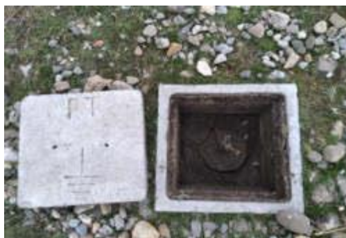
Fig. N° 41 UBICADO DETRÁS DE LA CONSTRUCCION DEL TAMBO, LADO IZQUIERDO, PRESENTA CAJA Y TAPA DE CONCRETO. (pozo a intervenir).
