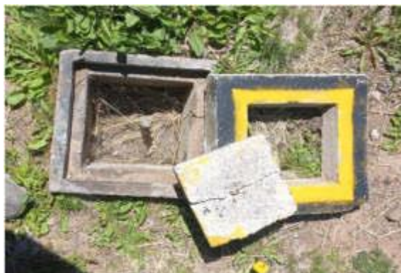
Fig. N° 13 UBICADO EN LA PARTE POSTERIOR, PRESENTA SULFATACION, (pozo a intervenir).
