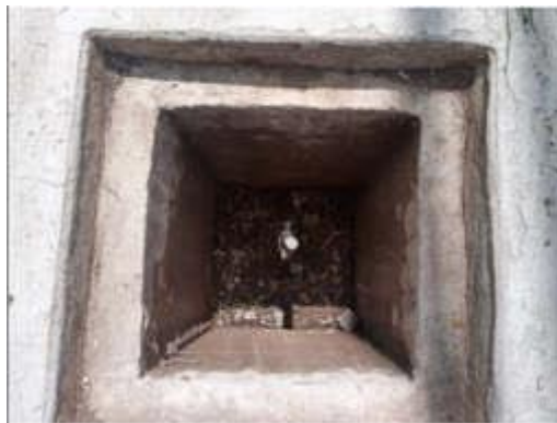
Fig. N° 29 UBICADO EN LADO IZQUIERDO EN LA PARTE DE LOS COSTADOS, PRESENTA TAPA DE CONCRETO QUEBRADA. (pozo a intervenir).
