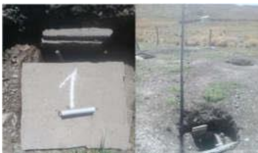
Fig. N° 27 UBICADO EN LA PARTE POSTERIOR, COSTADO IZQUIERDO, PRESENTA CAJA DE CONCRETO DETERIORADA, TAPA SIN PINTAR Y DAÑADA (pozo a intervenir).
