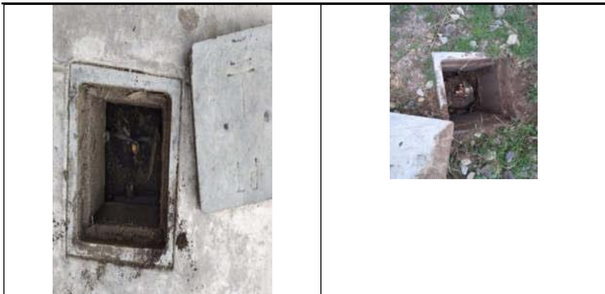
Fig. N° 42 POZOS UBICADOS ALREDEDOR DEL TAMBO, PARA CAMBIO DE CONECTOR, TAPA Y LIMPIEZA.
