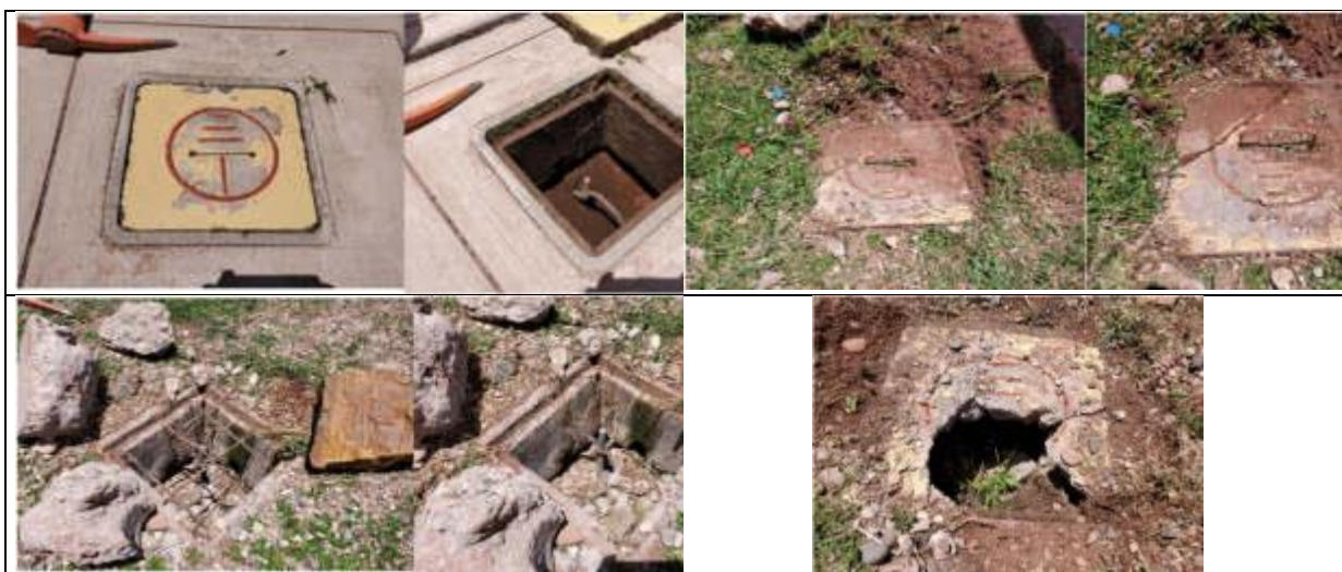
Fig. N° 31 UBICADO EN LA PARTE POSTERIOR, COSTADO IZQUIERDO, PRESENTA CAJA DE CONCENTRO DETERIORADO, (pozo a intervenir).
