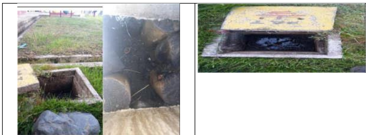
Fig. N° 39 UBICADO EN LA PARTE POSTERIOR IZQUIERDO DE LA PLATAFORMA, PRESENTA TAPA SIN PINTAR Y DETERIORO DEL INTERIOR DE LA CAJA, (pozo a intervenir).
