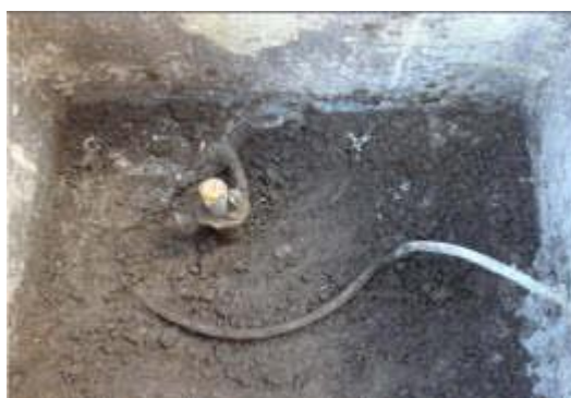
Fig. N° 22 UBICADO EN LA PARTE POSTERIOR, MEDIO, PRESENTA CAJA DE CONCENTRO SIN PINTAR, (pozo a intervenir).
