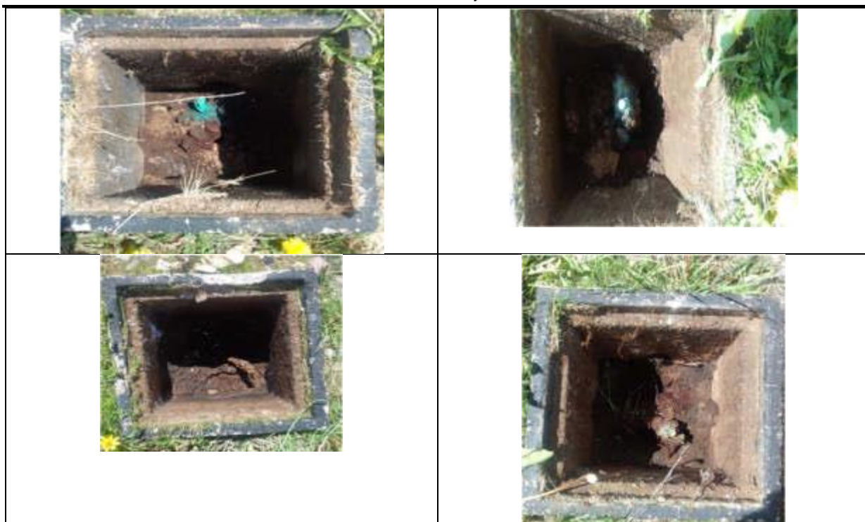
Fig. N° 34 POZOS UBICADOS ALREDEDOR DEL TAMBO, PARA CAMBIO DE CONECTOR, TAPA Y LIMPIEZA
