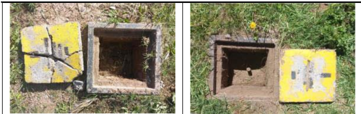
Fig. N° 14 POZOS UBICADOS ALREDEDOR DEL TAMBO, PARA CAMBIO DE CONECTOR, TAPA Y LIMPIEZA.
