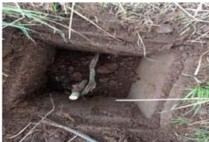
Fig. N° 35 UBICADO EN LA PARTE POSTERIOR, COSTADO IZQUIERDO, PRESENTA TAPA DE CONCRETO, PRESENTA CAJA DE CEMENTO SIN PINTAR, LOS ALAMBRES DE CONTACTO PRESENTAN DESGASTE OCACIONADO POR OXIDO, (pozo a intervenir).
