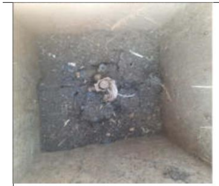
Fig. N° 37 UBICADO EN LA PARTE DELANTERA, COSTADO IZQUIERDO, PRESENTA CAJA DE CEMENTO CON TAPA DETERIORADA, (pozo a intervenir).
