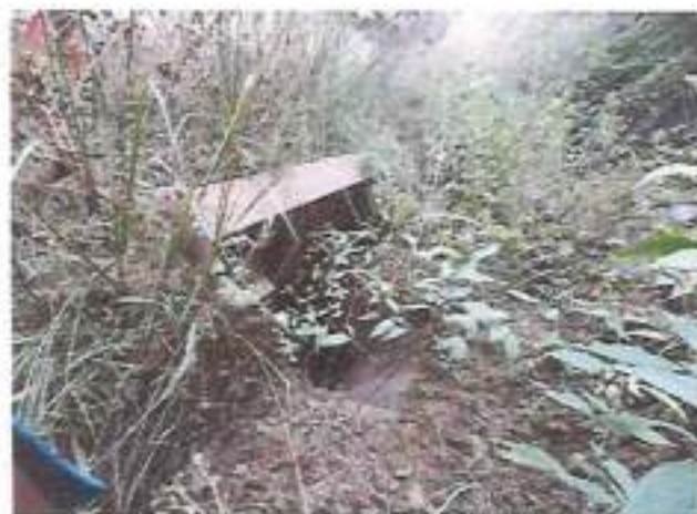
Foto N° 237 PROGRESIVA 33+640 DESCRIPCION Alcantarilla para limpiar
