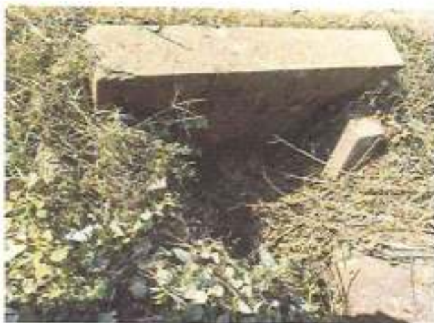
Foto N° 265 PROGRESIVA 45+140 DESCRIPCION Alcantarilla para limpiar
