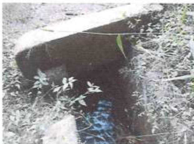
Foto N° 248 PROGRESIVA 38+810 DESCRIPCION Alcantarilla para limpiar
