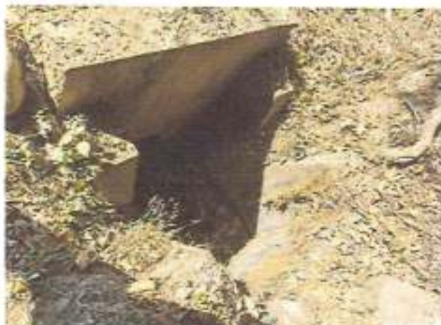
Foto N° 267 PROGRESIVA 47+260 DESCRIPCION Alcantarilla para limpiar
