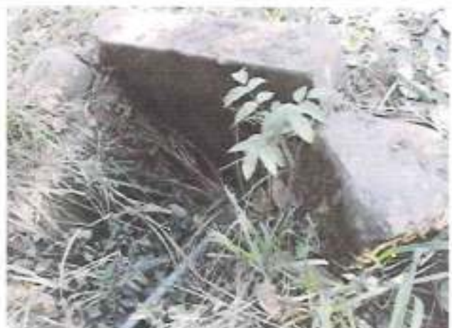
Foto N° 254 PROGRESIVA 39+460 DESCRIPCION Alcantarilla para limpiar
