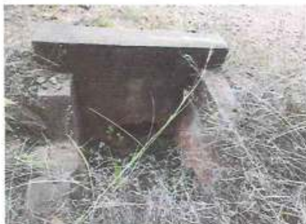
Foto N° 229 PROGRESIVA 32+150 DESCRIPCION Alcantarilla para limpiar
