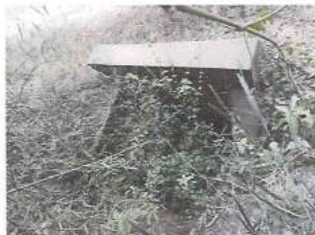
Foto N° 240 PROGRESIVA 34+090 DESCRIPCION Alcantarilla para limpiar
