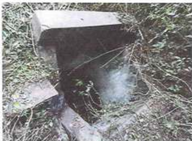
Foto N° 235 PROGRESIVA 33+450 DESCRIPCION Alcantarilla para limpiar
