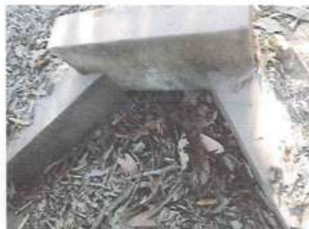
Foto N° 252 PROGRESIVA 39+280 DESCRIPCION Alcantarilla para limpiar
