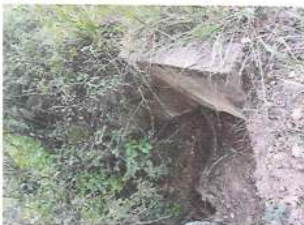
Foto N° 226 PROGRESIVA 31+335 DESCRIPCION Alcantarilla para limpiar
