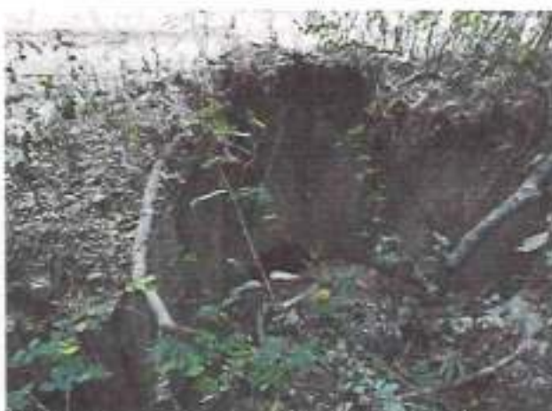
Foto N° 236 PROGRESIVA 33+530 DESCRIPCION Alcantarilla para limpiar
