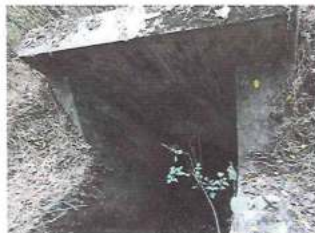
Foto N° 239 PROGRESIVA 33+980 DESCRIPCION Alcantarilla para limpiar
