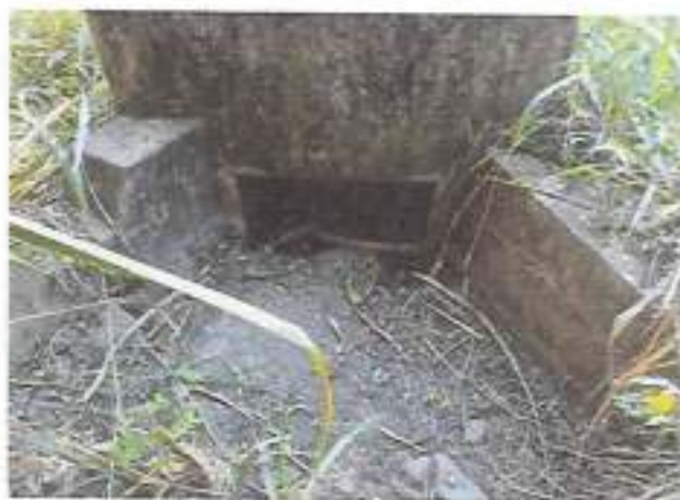
Foto N° 260 PROGRESIVA 40+360 DESCRIPCION Alcantarilla para limpiar
