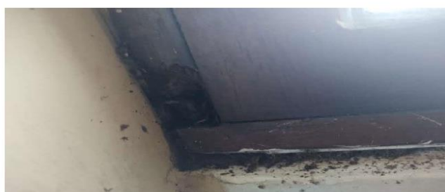
FIG. : FILTRACIONES DE AGUA DE LLUVIA EN LAS VENTANAS LATERALES
