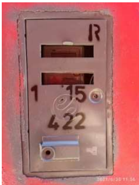
Imagen 03. Se observa medidor general de conexión aérea, ubicado en el lado derecho del módulo A empotrado en muro, sin señal de peligro y riesgo eléctrico.
