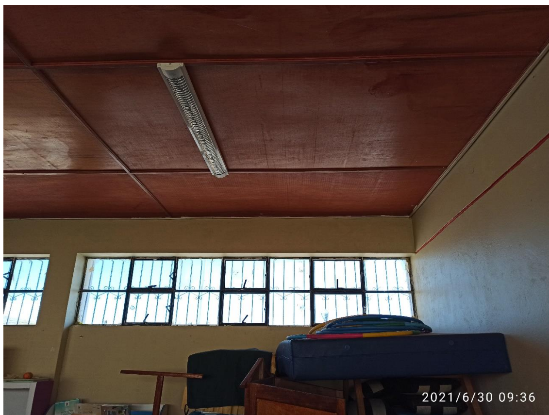
Fotografía 08: Se aprecia falso cielo raso en regular estado de conservación. Instalación de luminarias en regular estado de conservación
