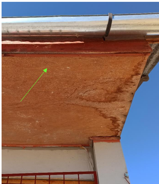
Fotografía 04 y 05: Elevación lateral izquierda del aula 01, se observa falso cielo raso deteriorado, la canaleta está instalado justo al borde del techo. Listones de madera apolillados sin protección de techo.
