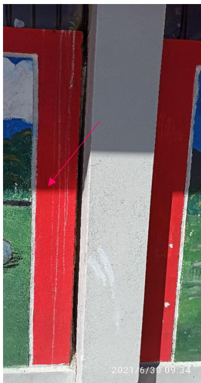
Fotografía 06 y 07: Juntas entre columnas y muros sin acabado y falta de relleno.
