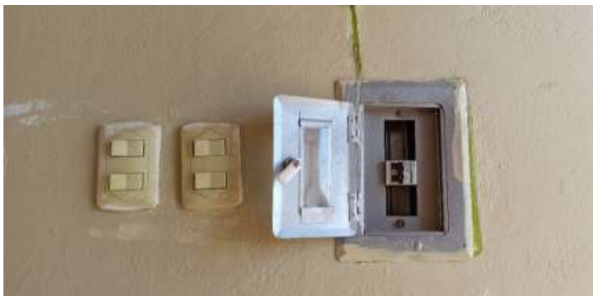
Imagen 01: Se observa interruptores manchados de pintura. El tablero de distribución se encuentra dentro del aula y no cuenta con pozo tierra, presenta caja metálica en estado de conservación regular. El tablero no tiene un directorio donde se indique los circuitos existentes, de manera visible. Presenta un interruptor termomagnético, no cuenta con interruptores diferenciales.
