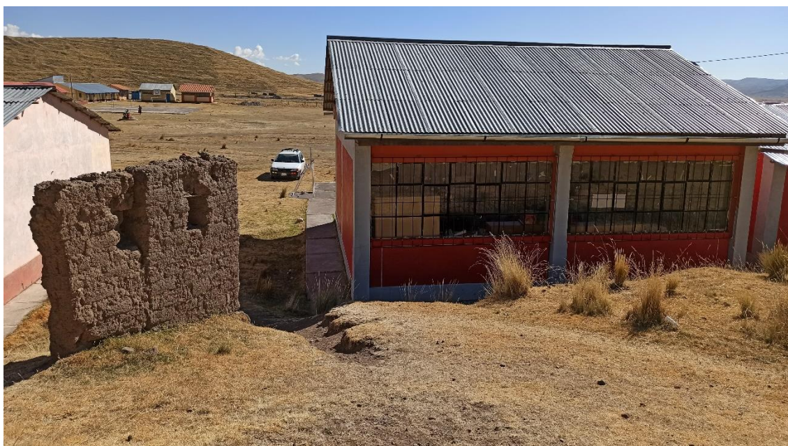
Fotografía 03: Elevación posterior del Aula 1, se aprecia desnivelado la cumbrera de techo de calamina, la canaleta presenta oxidación. Las ventanas presentan cerramiento con vidrio crudo.
