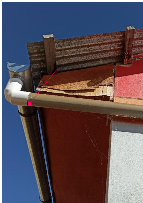
Fotografía 04 y 05: Elevación lateral izquierda del aula 01, se observa falso cielo raso deteriorado, la canaleta está instalado justo al borde del techo. Listones de madera apolillados sin protección de techo.
