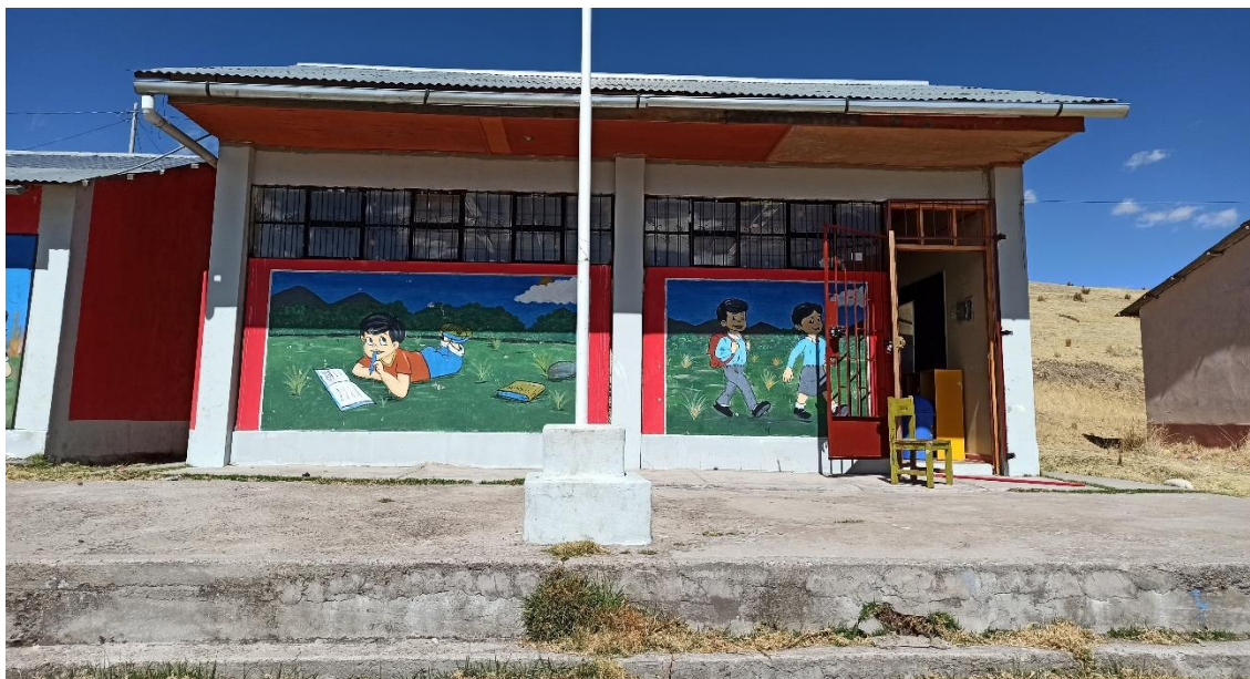
Fotografía 03: Se evidencia deterioro y fisuras en losa y gradas. Se observa ventanas con cerramiento de vidrios crudos, canaleta oxidado, falso cielo raso deteriorado por filtración de aguas de lluvia.
