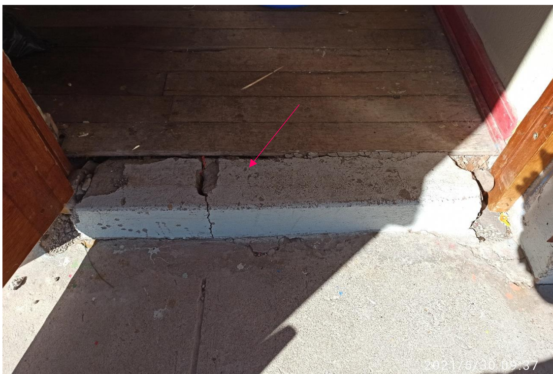
Fotografía 10: Derrame de puerta deteriorado, presenta fisura. Zócalo de madera en estado de conservación regular.
