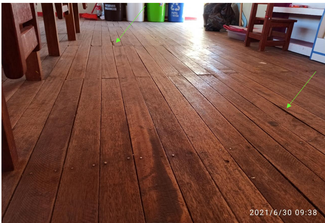
Fotografía 11: Piso entablado nivel de falso piso, se aprecia desnivelación y algunas tablas presentan quieños.
