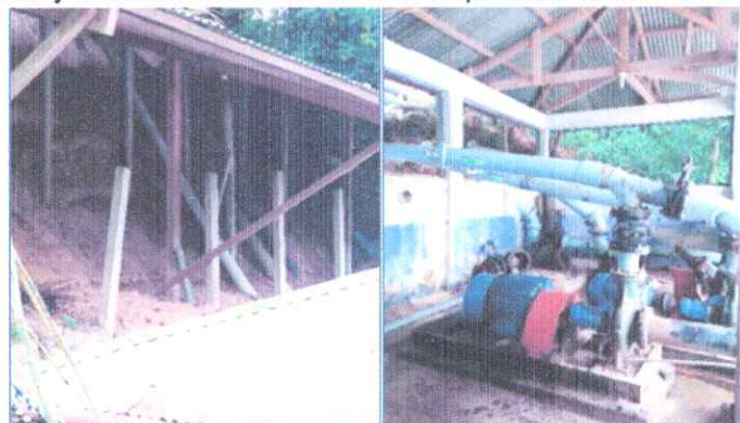
Imagen N° 03: Vista de la protección artesanal para evitar el deslizamiento de la caseta y del sistema de bombeo en la Captación del Río Parapapura
