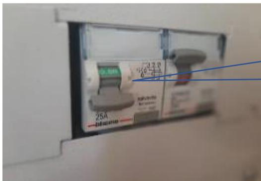
Servicio de mantenimiento de circuito de iluminación externa, considerando el cambio de llave diferencial, así como la revisión de equipos de iluminación externa y mejoramiento de empalmes eléctricos, así como la limpieza del tablero eléctrico, ordenamiento y ajuste de cableado interior, realizar el cambio de circuitos identificando problemas para proceder a su corrección.
