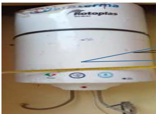
Suministro y colocación de terma eléctrica de 50 litros, en reemplazo de terma inoperativa; Consiste en remover terma malograda, instalar nueva terma: revisión y corrección de las conexiones de agua fría y caliente con acoples, inc. Accesorios, fijación de la terma al muro. Verificar el correcto funcionamiento de la instalación (mediante prueba de funcionamiento) y la correcta fijación al muro.
