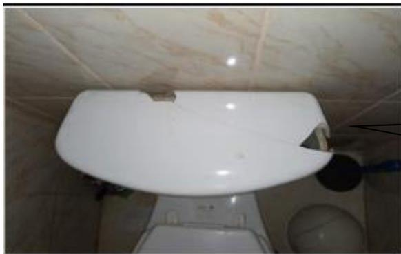
Suministro e instalación de Tapas de Inodoros (incluye la desinstalación de tapa deteriorada ,instalación y puesta de funcionamiento de la misma ).
