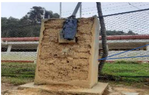
Servicio de mantenimiento de murete para medidor eléctrico, consiste en el suministro e instalación de murete de ladrillo pandereta 12cmx23cmx10cm de medidas 1.00mx1.00m, adicionalmente ello considera un sobrecimiento de 1.00mx0.10mx0.30m.con varilla de 1/4 cada 20 cm (vertical y horizontal) e instalar el medidor en el murete de ladrillo. Incluye materiales cemento, ladrillo acero, madera para encofrado y herramientas para su funcionamiento
