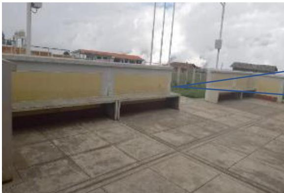
Servicio de mantenimiento de pintura oleo mate para paredes exteriores, muro cortaviento. Consiste en la remoción de toda la pintura y tarrajeo existente hasta llegar al ladrillo, aplicación de aditivo impermeabilizante en pared, volver a tarrapear, lijado, sellado con resinas acrílicas, enmasillado con pasta mural, lijado y pintado con pintura oleo mate a dos manos (Color de la pintura igual a la existente tanto para muros, columnas y zócalos).
