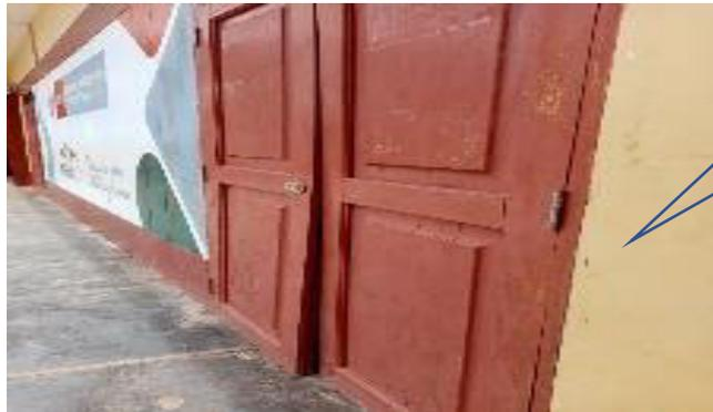
Suministro mantenimiento de puertas de madera (inc. desmontaje de puerta existente deteriorada , Cambio de marco + hoja de puerta, sellado, pegado, lijado, tinte , barnizado, cambio de accesorios, montaje de puerta en ambiente de Auditorio(medidas 1.80mx2.60m) .
