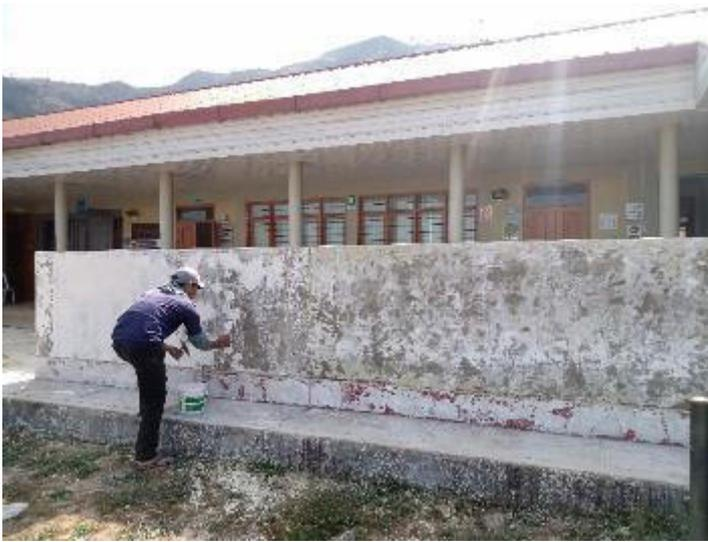
Servicio de mantenimiento de pintura oleo mate para paredes exteriores, incluido el muro cortaviento. Consiste en la remoción de toda la pintura lijado, sellado con resinas acrílicas, enmasillado con pasta mural, lijado y pintado con pintura oleo mate a dos manos (Color de la pintura igual a la existente tanto para muros, columnas y zócalos).
