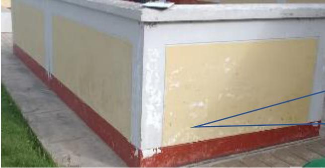
Servicio de mantenimiento de pintura oleo mate para paredes exteriores, muro cortaviento. Consiste en la remoción de toda la pintura y tarrajeo existente hasta llegar al ladrillo, aplicación de aditivo impermeabilizante en pared, volver a tarrajar, lijado, sellado con resinas acrílicas, enmasillado con pasta mural, lijado y pintado con pintura oleo mate a dos manos (Color de la pintura igual a la existente tanto para muros, columnas y zócalos).
