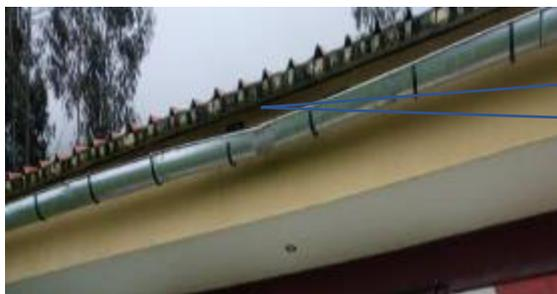
Servicio de mantenimiento en canaletas de drenaje ,consiste en suministro e instalación de soportes/Abrazaderas(15 und),fijación y Corregir las canaletas desajustadas que cuelgan).
