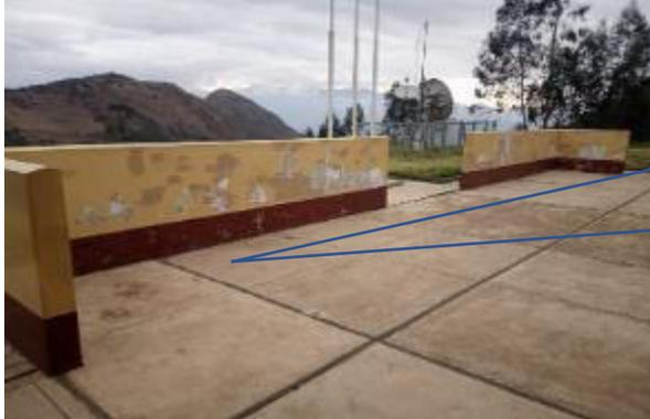
Servicio de mantenimiento de pintura oleo mate para paredes exteriores, muro cortaviento. Consiste en la remoción de toda la pintura y tarrajeo existente hasta llegar al ladrillo, aplicación de aditivo impermeabilizante en pared, volver a tarrajar, lijado, sellado con resinas acrílicas, enmasillado con pasta mural, lijado y pintado con pintura oleo mate a dos manos (Color de la pintura igual a la existente tanto para muros, columnas y zócalos).
