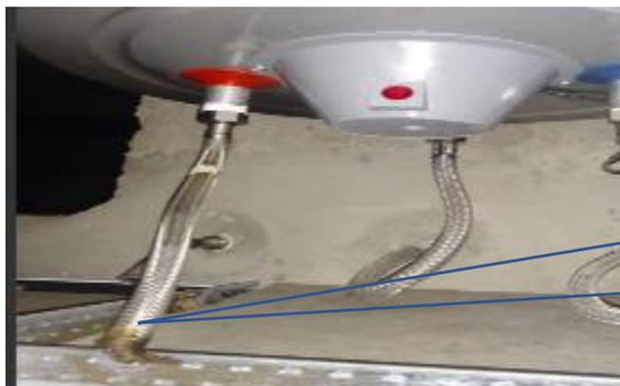
Servicio de mantenimiento de manera para terma, red agua caliente, consiste en el desmontaje de la manguera en mal estado y el remplazo por una manguera del mismo tipo, constara de una visita para verificar el tipo de manguera a realizar el trabajo.
