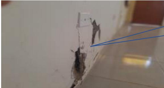
Servicio de mantenimiento de reparación de pared, Consiste en la remoción del tarrajeo existente (reventado), limpiado hasta llagar al ladrillo, empastado con pasta de concreto, tarrajeado para su posterior pintado.
