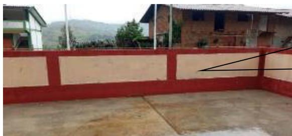
Servicio de mantenimiento de pintura oleo mate para paredes exteriores, muro cortaviento. Consiste en la remoción de toda la pintura y tarrajeo existente hasta llegar al ladrillo, aplicación de aditivo impermeabilizante en pared, volver a tarrajar, lijado, sellado con resinas acrílicas, enmasillado con pasta mural, lijado y pintado con pintura oleo mate a dos manos (Color de la pintura igual a la existente tanto para muros, columnas y zócalos).
