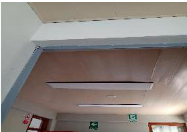
Servicio de mantenimiento de suministro e Instalación de panel 120x30cm LED 48W, con voltaje 110-240, luz fría para interiores, incluye retiro de luminaria averiada, considerar el cambio de drivers y accesorios, caja panel, etc. La ubicación coordinar con el gestor.
