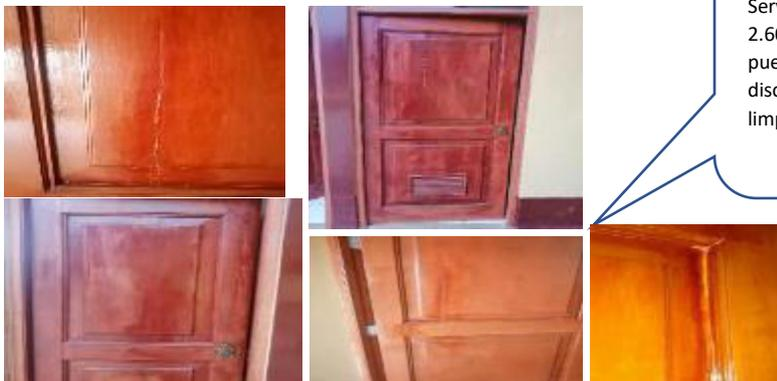
Servicio de mantenimiento de barnizado de puertas de 2.00m x 2.60m (Oficina 0.9x2.2, cuarto de tableros 0.93x2.10, multiusos puerta 2 hojas 1.13x2.9 mas marcos las dos puertas, baño de discapacitados 0.95x2.10) consta y marco de madera. Incluye limpieza, lijado, enmasillado, tinte y barnizado..
