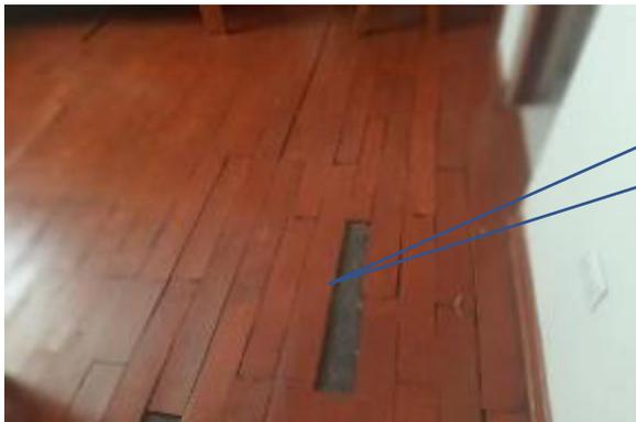
Suministro e instalación de piso Machihembrado en ambiente de oficina .Incluye retiro de piso dañado ,accesorios e instalación de nuevo piso parquet (3.4mx4.15m) ,herramientas y puesta en funcionamiento)
