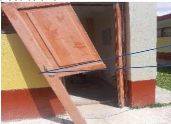
Suministro e instalación de puerta de madera en ambientes de cuarto de bomba de agua de medidas 0.675m x 2.05 m respectivamente. Incluye desmontaje de puerta existente deteriorada, Cambio de marco + hoja de puerta, sellado, pegado, lijado, tinte, barnizado, cambio de accesorios, montaje de puerta y chapa en ambientes de Oficina (3 golpes).
