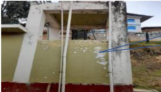
Servicio de mantenimiento de pintura en exteriores en Estructura de tanque elevado (4 columnas de 0.35x0.20x3.0m losa de techo 1.60x1.90 y muro (12m2). consiste en: - Lijar la superficie, aplicar sellador, empastar para nivelar, lijar y aplicar dos manos de pintura oleo mate amarillo maracuyá)
