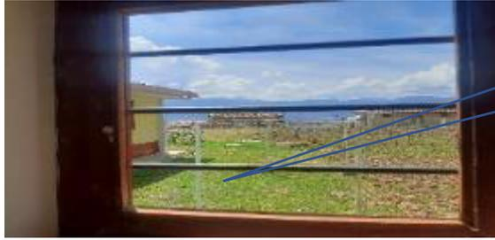
Suministro e instalación de vidrios para ventanas de e=2mm de 38.5cm x 38.5cm. con su correspondiente instalación.
