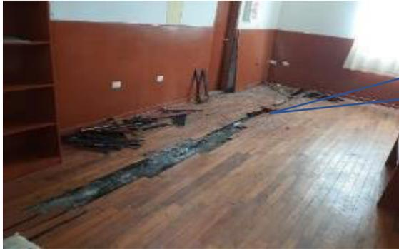
Suministro e instalación de piso Machihembrado en ambiente de oficina. Incluye retiro de piso dañado, accesorios e instalación de nuevo piso, herramientas y puesta en funcionamiento)
