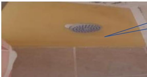
Suministro e instalación de grifería de ducha en ambientes de baño del guardián. incluye retiro de grifería dañada e instalación de nuevas griferías.
