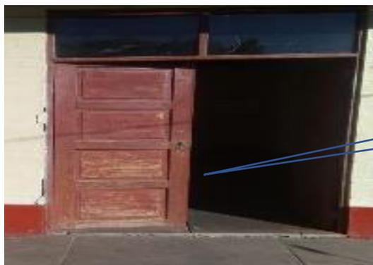
Servicio de mantenimiento de barnizado de puerta de madera 1.58m X 2.5m (OFICINA) consta de una hoja y marco de madera. Incluye limpieza, lijado, enmasillado, tinte y barnizado.
