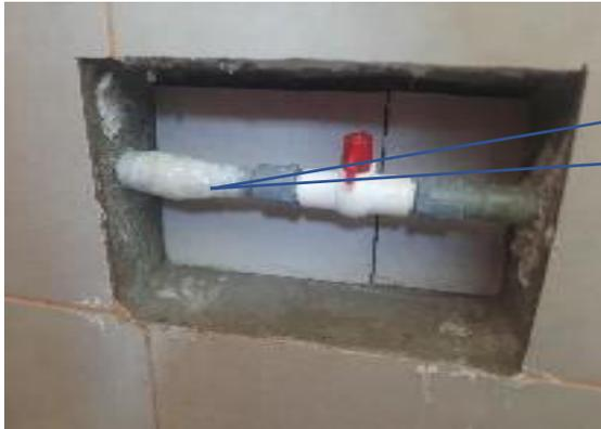
Servicio de reparación de fuga de agua en un ambiente (Baño mujeres), cambio de tubería de 1/2" (01 und=3m), ( uniones y pegamentos). (Incluye. Retiro de tuberías dañadas y accesorios para la instalación).
