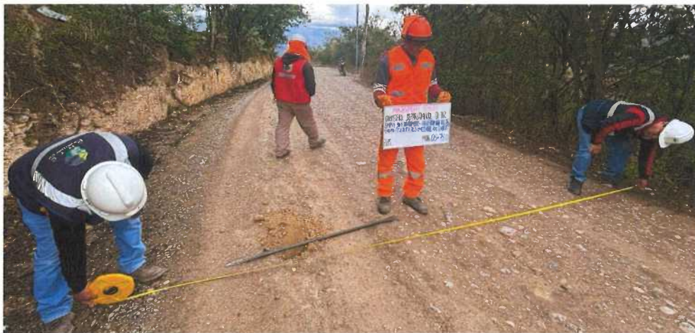
Fotografía N° 16: Medidas de superficie de rodadura, Progresivas 05+750
