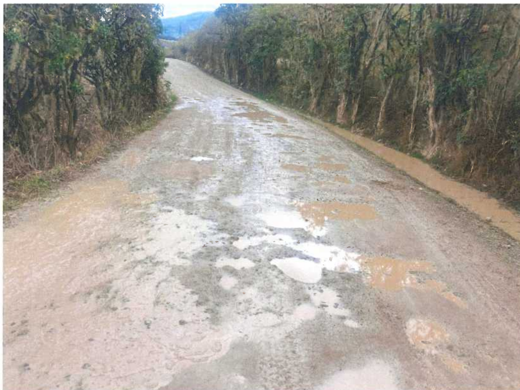
Fotografía N°09: Baches graves, progresiva km 05+500
