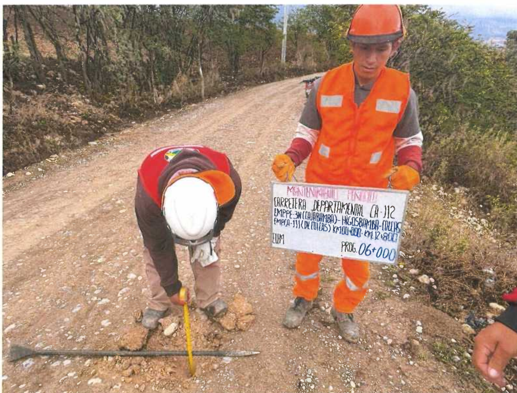
Fotografía 24: Calicata 24, Progresiva KM 06+000
