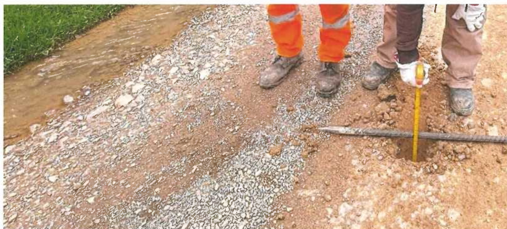
Fotografía N° 6: Ahuellamiento, erosión y baches, progresiva KM 01+500
