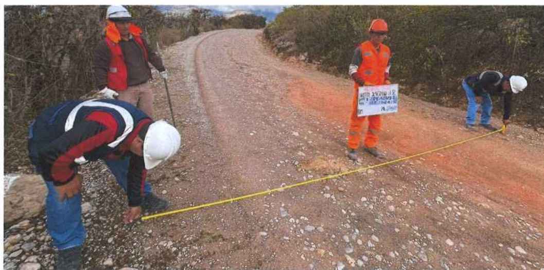
Fotografía N° 23: Medidas de superficie de rodadura, Progresivas 07+500
