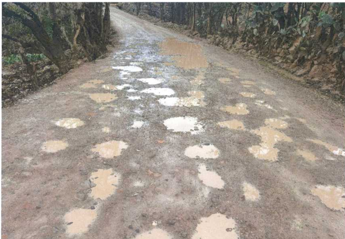
Fotografía N°11: baches graves, progresiva km -06+750
