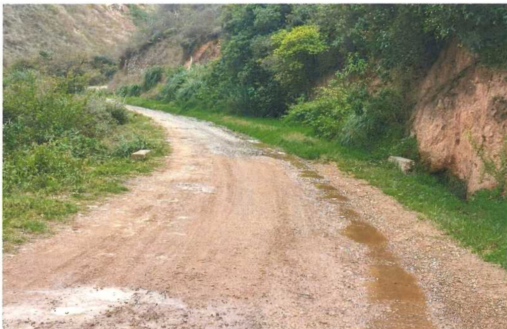
Fotografía N°07: Erosiones y Ahuellamiento graves, progresiva km 01+750
