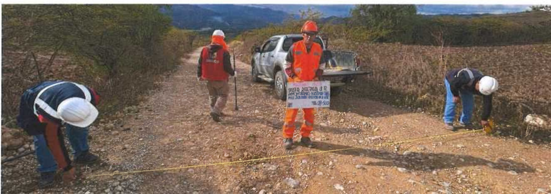
Fotografía N° 27: Medidas de superficie de rodadura, Progresivas 08+500
