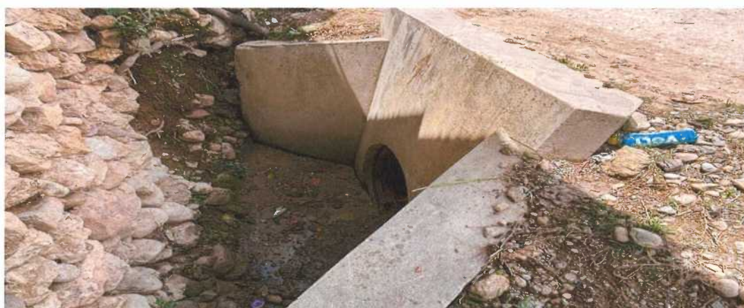
Fotografía N° 09– KM 04+800 ALCANTARILLA
