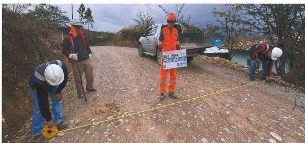
Fotografía N° 18: Medidas de superficie de rodadura, Progresivas 06+250
