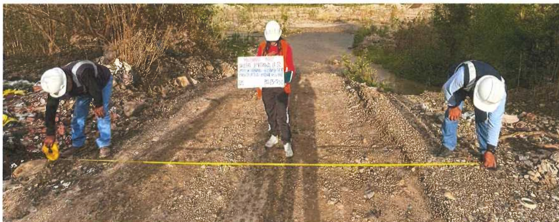
Fotografía N° 43: Medidas de superficie de rodadura, Progresivas 13+750
