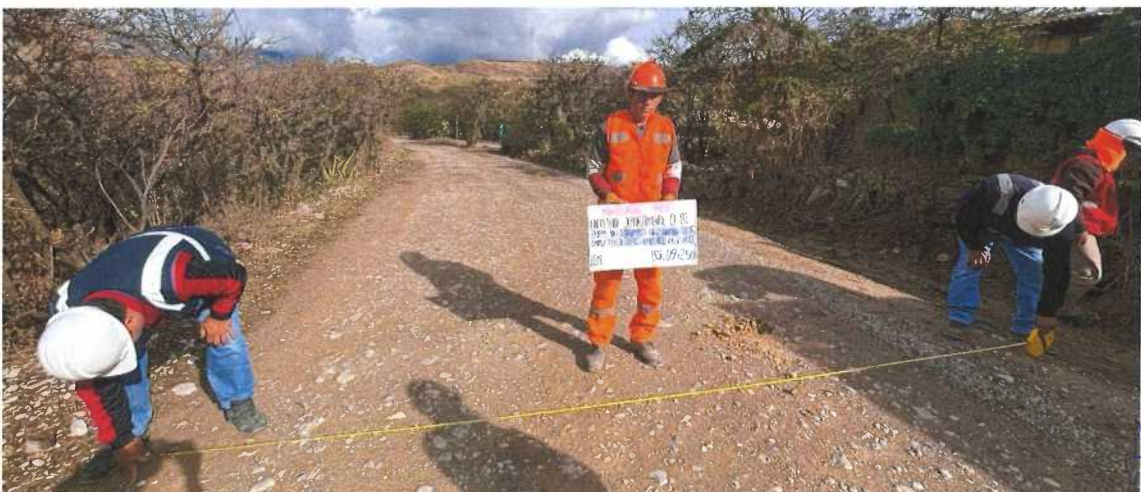
Fotografía N° 30: Medidas de superficie de rodadura, Progresivas 09+250
