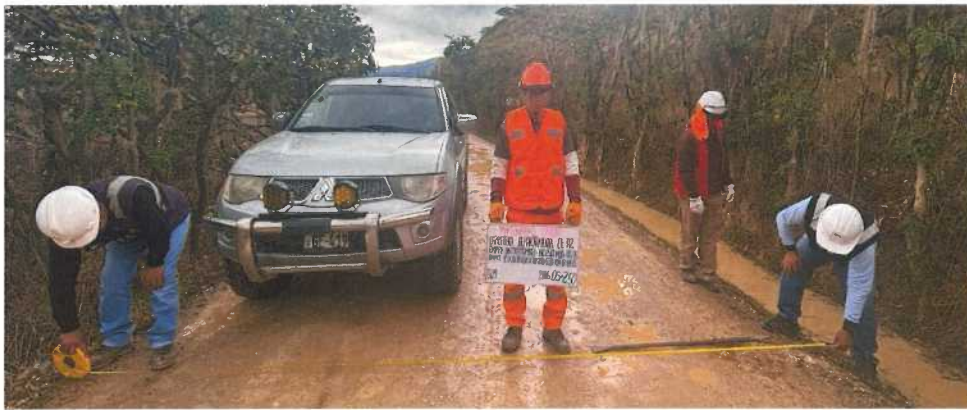
Fotografía N° 14: Medidas de superficie de rodadura, Progresivas 05+250
