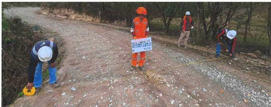
Fotografía N° 22: Medidas de superficie de rodadura, Progresivas 07+250
