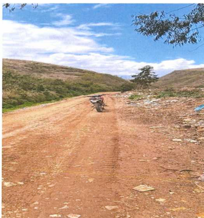
Fotografía N° 4: Ahuellamiento, progresiva KM 01+00.
