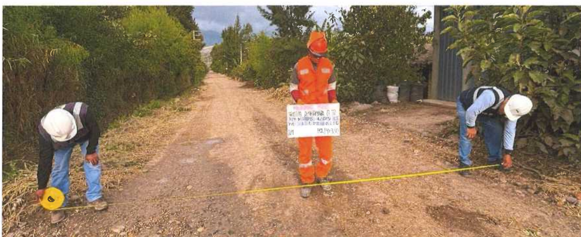
Fotografía N° 44: Medidas de superficie de rodadura, Progresivas 14+350
