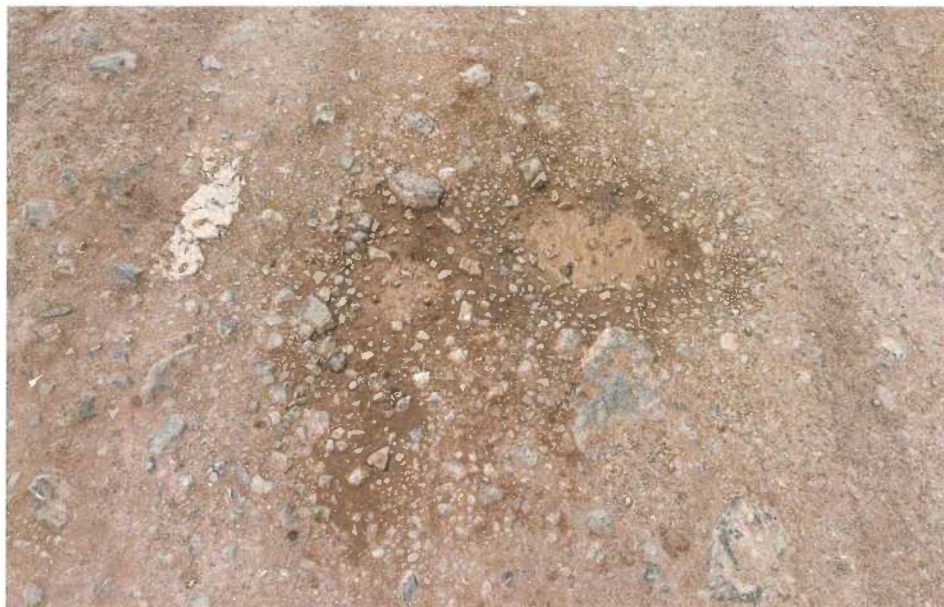
Fotografía N° 1: Baches, progresiva KM 00+250
