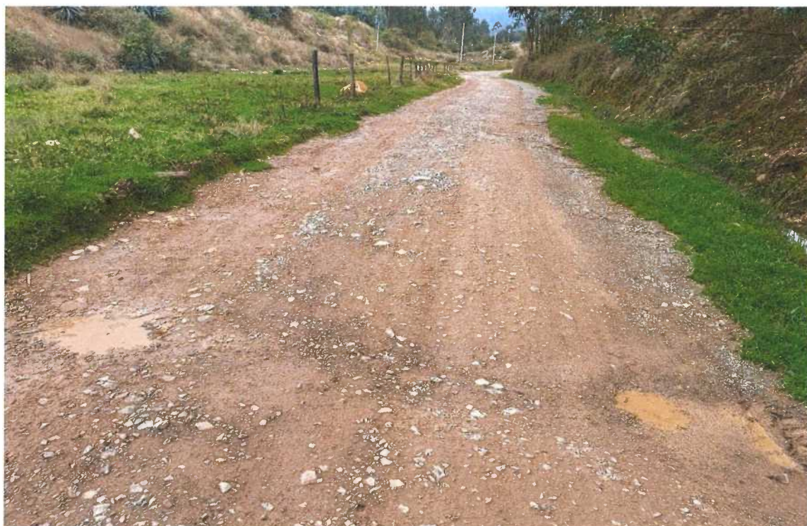
Fotografía N° 3: Ahuellamiento, progresiva KM 750
