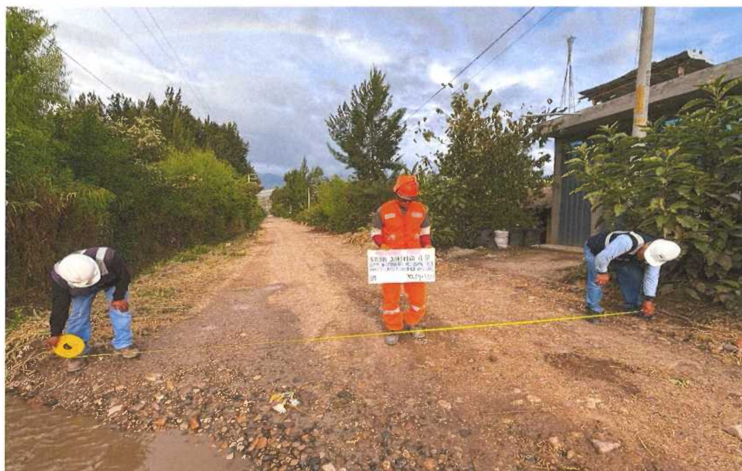
Fotografía N°16: Presencia de ahuellamiento, progresiva km 14+350
