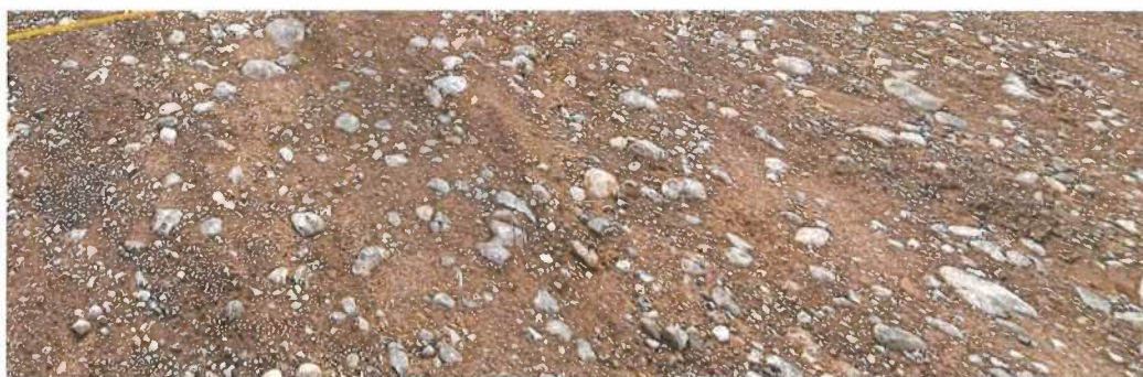
Fotografía N°13: erosión y ahuellamiento severos, progresiva km 08+000
