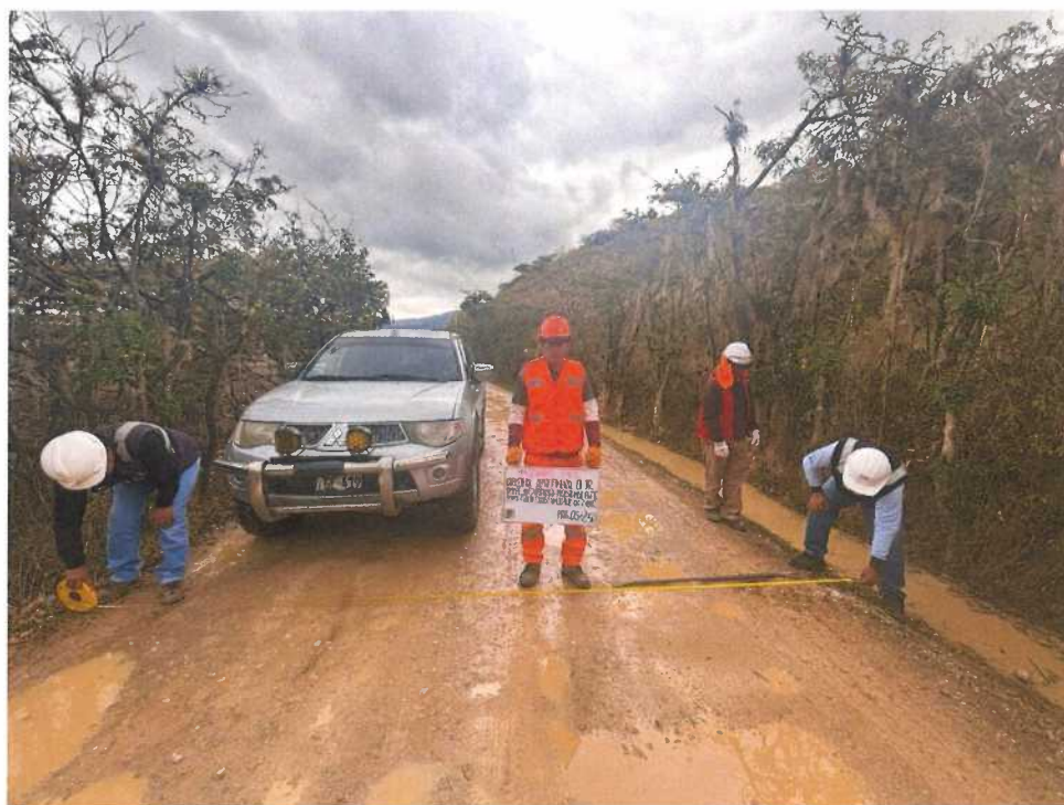
Fotografía N°08: Baches graves, progresiva km 05+000-05+250
