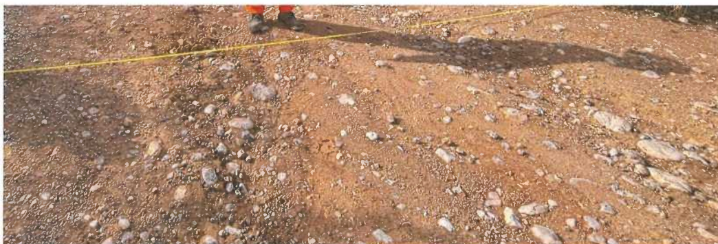
Fotografía N°14: erosión y ahuellamiento severos, progresiva km 08+500
