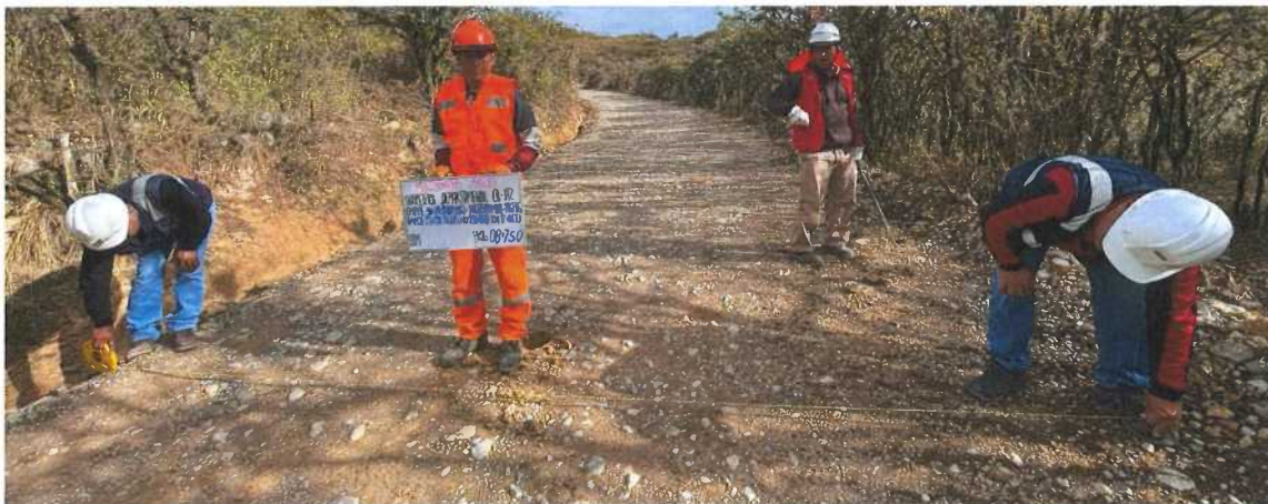
Fotografía N° 28: Medidas de superficie de rodadura, Progresivas 08+750
