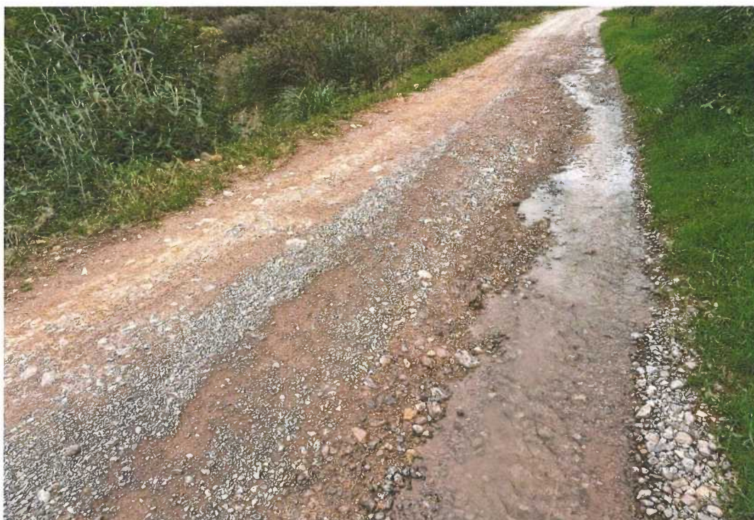
Fotografía N° 5: Ahuellamiento, progresiva KM 01+250
