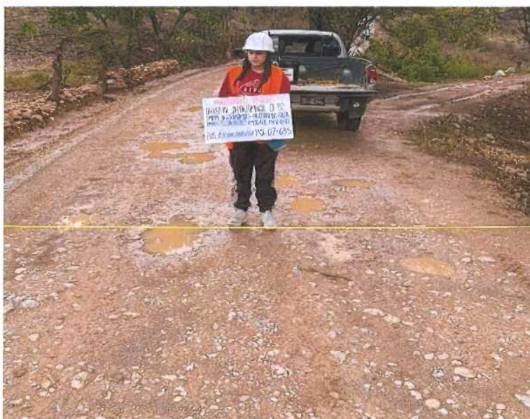
Fotografía N°12: erosión y baches severos, progresiva km 07+750
