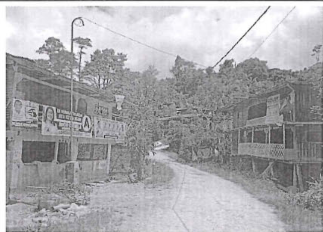
Foto 246: El tramo evaluado desde la prog. 8+380 a la prog. 8+495, presenta daños de tipo Erosion , los cuales son de nivel de gravedad: 1. alcanzando 2.1m de ancho de deterioro
