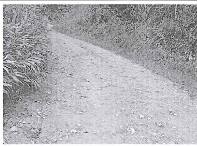
Foto 282: El tramo evaluado desde la prog. 5+310 a la prog. 5+490, presenta daños de tipo Erosion, los cuales son de nivel de gravedad: 1. alcanzando 1.9m de ancho de deterioro.
