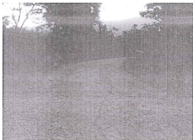
Foto 184: Superficie de Rodadura de afirmado, en estado de transitabilidad bueno prog. 6+500.
