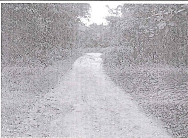
Foto 279: El tramo evaluado desde la prog. 4+520 a la prog. 4+740, presenta daños de tipo Erosion , los cuales son de nivel de gravedad: 1. alcanzando 1.8m de ancho de deterioro.
