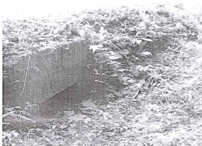
Foto 62: Alcantarilla de concreto, en buena condición Prog. 4+760
