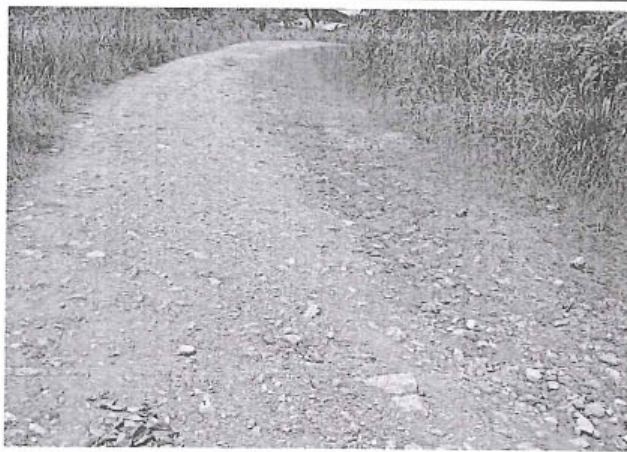
Foto 287: El tramo evaluado desde la prog. 6+520 a la prog. 6+720, presenta daños de tipo Erosion, los cuales son de nivel de gravedad: 2. alcanzando 2.2m de ancho de deterioro.
