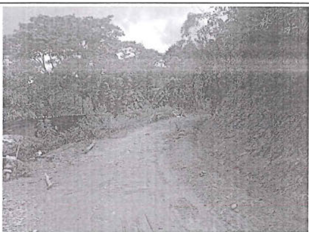
Foto 272: El tramo evaluado desde la prog. 12+640 a la prog. 12+850, presenta daños de tipo Erosion , los cuales son de nivel de gravedad: 1. alcanzando 1.8m de ancho de deterioro
