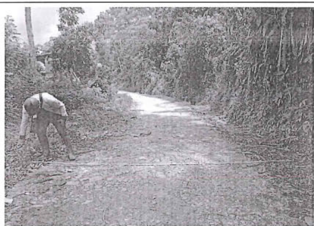
Foto 248: El tramo evaluado desde la prog. 8+770 a la prog. 8+990, presenta daños de tipo Erosion , los cuales son de nivel de gravedad: 2. alcanzando 2.1m de ancho de deterioro
