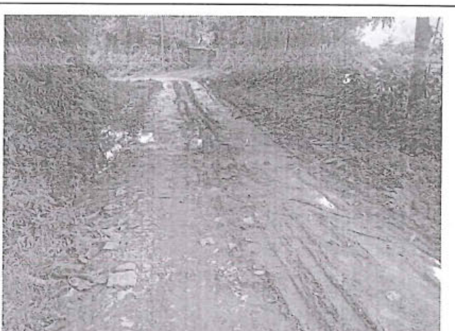
Foto 266: El tramo evaluado desde la prog. 11+630 a la prog. 11+683, presenta daños de tipo Baches, encontrandose 7, los cuales son de nivel de gravedad: 2.
