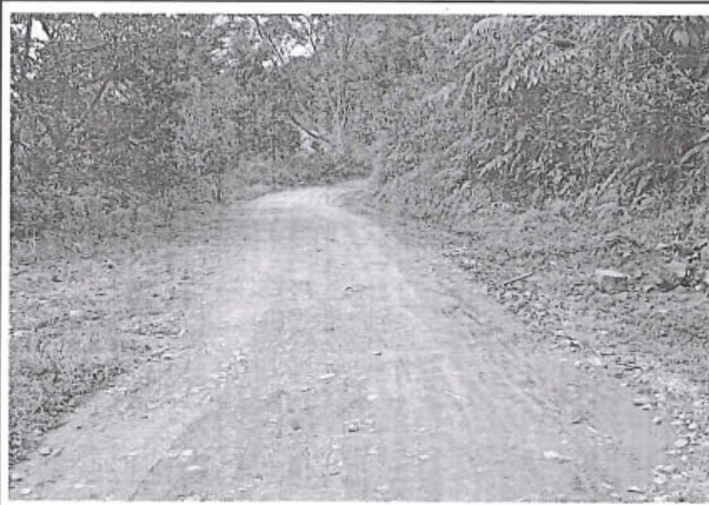
Foto 275: El tramo evaluado desde la prog. 3+850 a la prog. 3+990, presenta daños de tipo Erosion , los cuales son de nivel de gravedad: 1. alcanzando 2.1m de ancho de deterioro.
