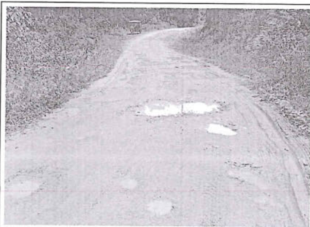
Foto 193: El tramo evaluado desde la prog. 0+470 a la prog. 0+495, presenta daños en la calzada de tipo Baches , de nivel de gravedad: 2.
