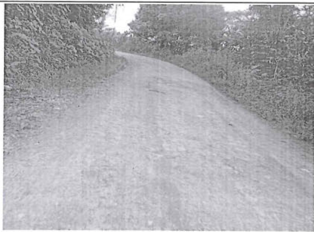
Foto 227: El tramo evaluado desde la prog. 4+870 a la prog. 4+990, presenta daños de tipo Erosion , nivel de gravedad 1 , ancho de deterioro de 1.2m.
