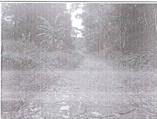
Foto 267: El tramo evaluado desde la prog. 11+720 a la prog. 11+990, presenta daños de tipo Erosion, los cuales son de nivel de gravedad: 1. alcanzando 2.1m de ancho de deterioro
