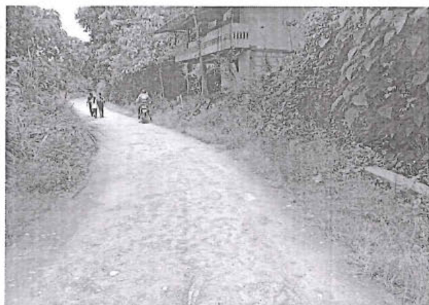
Foto 239: El tramo evaluado desde la prog. 7+100 a la prog. 7+390, presenta daños de tipo Erosion , los cuales son de nivel de gravedad: 1. alcanzando 1.5m de ancho de deterioro.
