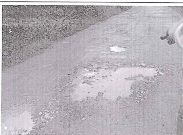
Foto 218: El tramo evaluado desde la prog. 3+680 a la prog. 3+750, presenta daños en la calzada de tipo Baches, de nivel de gravedad: 2.
