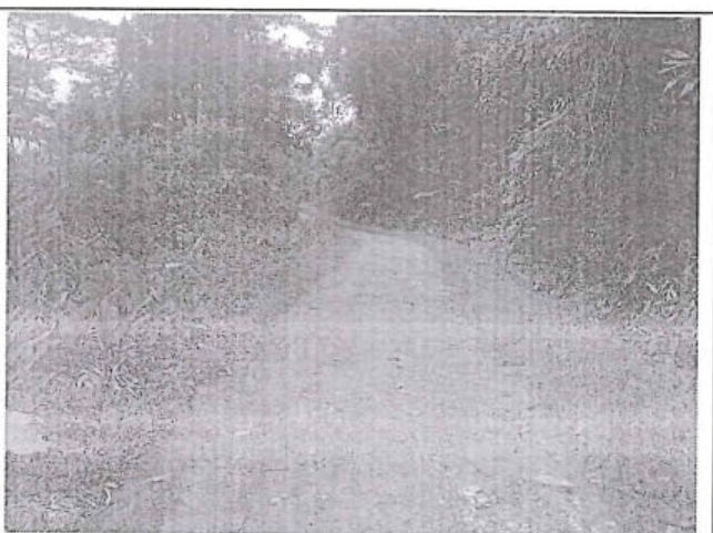
Foto 268: El tramo evaluado desde la prog. 12+045 a la prog. 12+190, presenta daños de tipo Erosion, los cuales son de nivel de gravedad: 1. alcanzando 2.1m de ancho de deterioro
