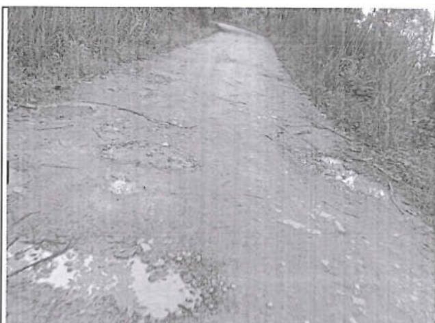
Foto 216: El tramo evaluado desde la prog. 3+300 a la prog. 3+360, presenta daños de tipo Baches , encontrándose 6, los cuales son de nivel de gravedad: 2.
