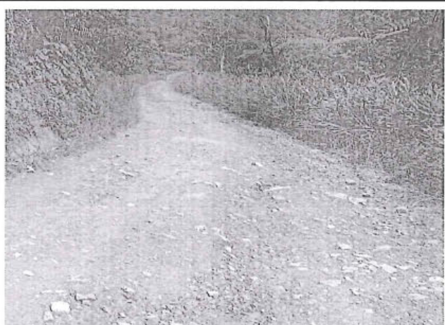
Foto 286: El tramo evaluado desde la prog. 6+260 a la prog. 6+490, presenta daños de tipo Erosion, los cuales son de nivel de gravedad: 2. alcanzando 2.2m de ancho de deterioro.
