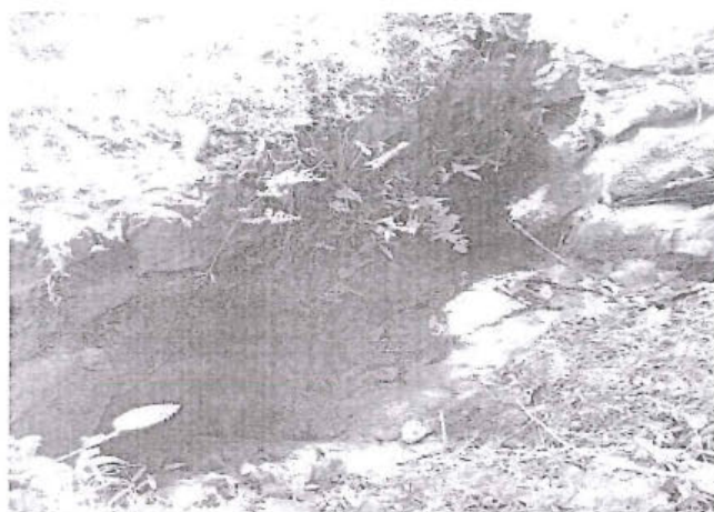
Foto 82: Alcantarilla de concreto, en buena condición Prog. 6+265
