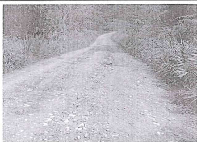
Foto 285: El tramo evaluado desde la prog. 6+020 a la prog. 6+230, presenta daños de tipo Erosion, los cuales son de nivel de gravedad: 2. alcanzando 2.2m de ancho de deterioro.
