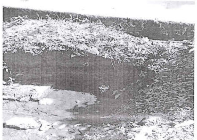
foto 44: Alcantarilla de concreto, obstruido pero en buena condición Prog. 3+420
