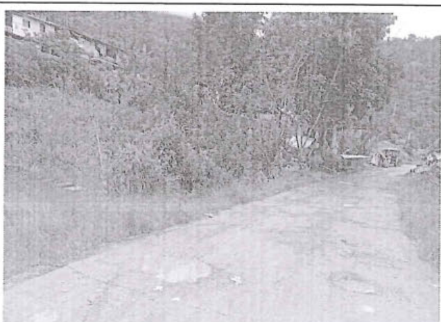
Foto 220: El tramo evaluado desde la prog. 3+910 a la prog. 3+990, presenta daños en la calzada de tipo Baches, de nivel de gravedad: 2.
