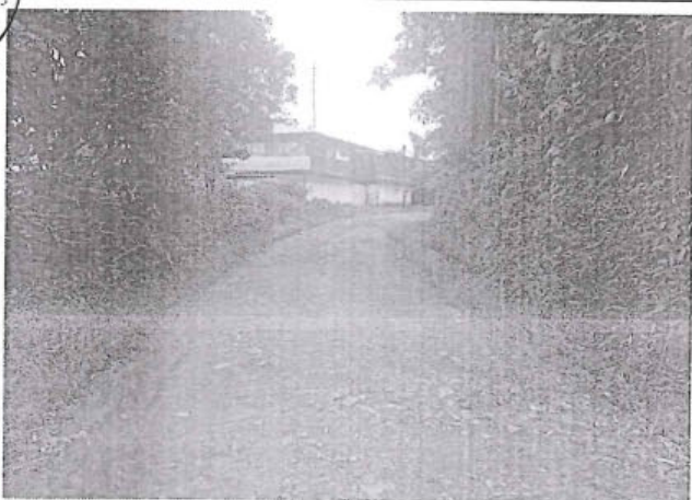
Foto 237: El tramo evaluado desde la prog. 6+740 a la prog. 6+985, presenta daños en la calzada de tipo Erosion , de nivel de gravedad: 1, alcanzando 1.70 m. de ancho de deterioro.
