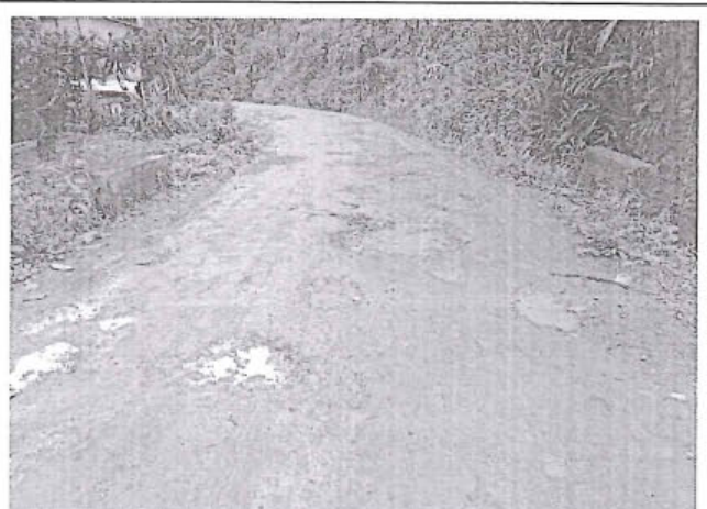
Foto 208: El tramo evaluado desde la prog. 2+390 a la prog. 2+420, presenta daños en la calzada de tipo Baches , de nivel de gravedad: 2.
