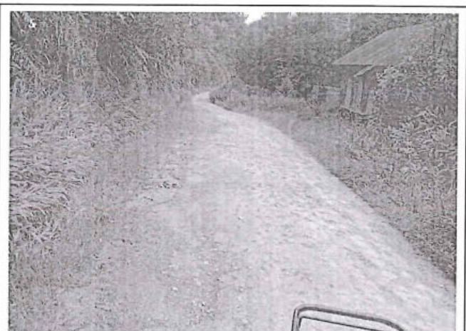
Foto 278: El tramo evaluado desde la prog. 4+370 a la prog. 4+490, presenta daños de tipo Erosion , los cuales son de nivel de gravedad: 1. alcanzando 1.9m de ancho de deterioro.
