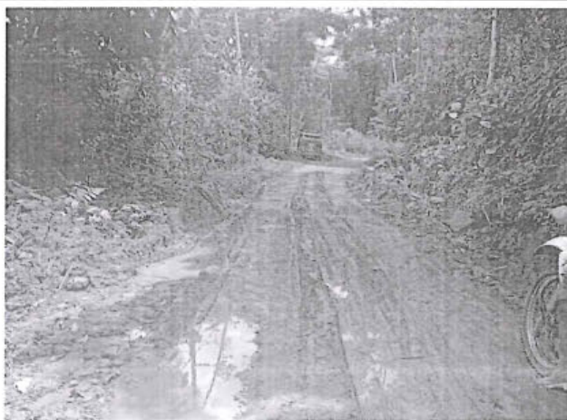
Foto 257: El tramo evaluado desde la prog. 10+460 a la prog. 10+490, presenta daños de tipo Baches , encontrándose 9, los cuales son de nivel de gravedad: 2.
