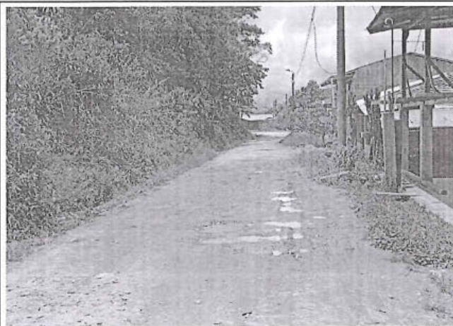
Foto 245: El tramo evaluado desde la prog. 8+330 a la prog. 8+360, presenta daños de tipo Baches , encontrándose 10, los cuales son de nivel de gravedad: 1.
