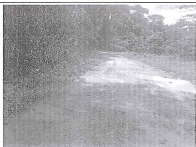
Foto 270: El tramo evaluado desde la prog. 12+470 a la prog. 12+494, presenta daños de tipo Baches , encontrándose 7, los cuales son de nivel de gravedad: 2.
