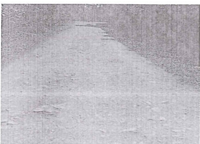
Foto 90: Superficie de Rodadura de afirmado, en estado de transitabilidad bueno prog. 7+500.
