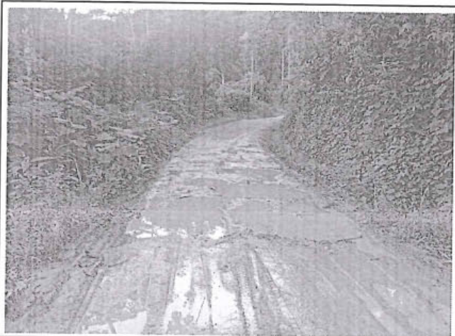
Foto 238: El tramo evaluado desde la prog. 7+035 a la prog. 7+085, presenta daños de tipo Baches , encontrandose 12, los cuales son de nivel de gravedad: 2.
