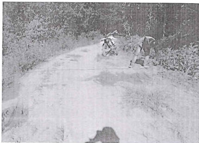
Foto 152: Superficie de Rodadura de afirmado, en estado de transitabilidad regular prog. 0+500.
