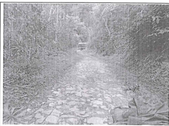
Foto 264: El tramo evaluado desde la prog. 11+250 a la prog. 11+490, presenta daños en la calzada de tipo Erosion, de nivel de gravedad: 2, alcanzando 2.10 m. de ancho de deterioro.
