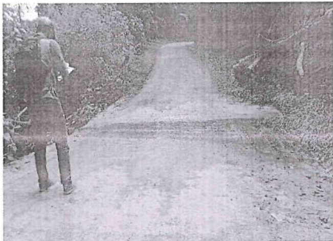
Foto 7: Baden en la prog. 0+460 con superficie de rodadura con afirmado y estado de transitabilidad bueno.
