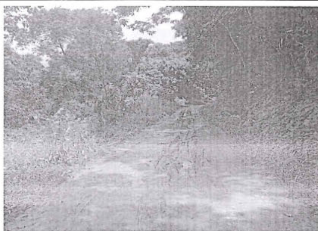
Foto 261: El tramo evaluado desde la prog. 11+020 a la prog. 11+090, presenta daños de tipo Baches , encontrándose 9, los cuales son de nivel de gravedad: 2.
