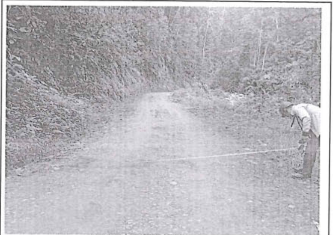
Foto 232: El tramo evaluado desde la prog. 5+860 a la prog. 5+990, presenta daños en la calzada de tipo Erosión , de nivel de gravedad: 2 , alcanzando 1.50 m. de ancho de deterioro.
