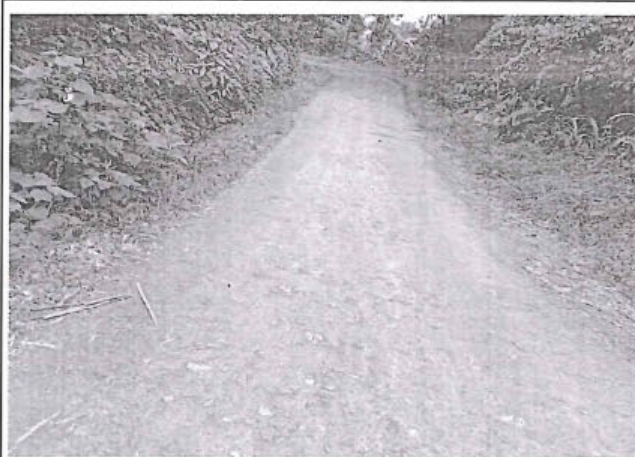
Foto 241: El tramo evaluado desde la prog. 7+518 a la prog. 7+720, presenta daños de tipo Erosion , los cuales son de nivel de gravedad: 1. alcanzando 1.9m de ancho de deterioro
