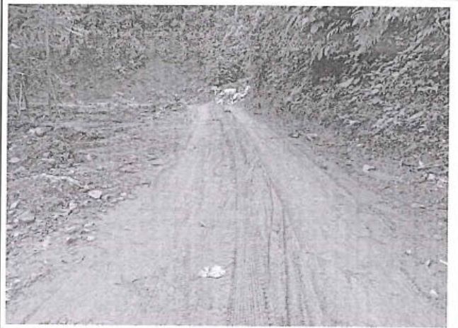
Foto 230: El tramo evaluado desde la prog. 5+540 a la prog. 5+650, presenta daños de tipo Deformacion , nivel de gravedad 2 , alcanzando 2.1m de ancho de deterioro.
