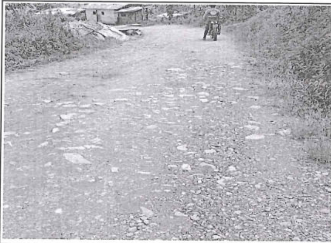
Foto 191: El tramo evaluado desde la prog. 0+040 a la prog. 0+290, presenta daños en la calzada de tipo Erosión , de nivel de gravedad: 2, alcanzando 1.60 m. de ancho de deterioro.
