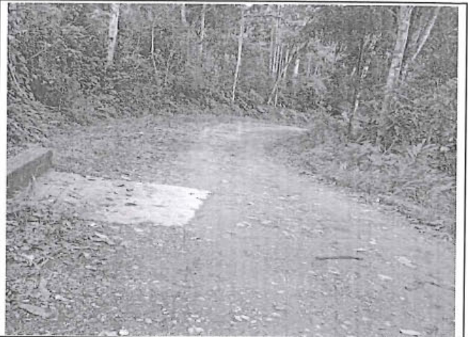
Foto 228: El tramo evaluado desde la prog. 5+020 a la prog. 5+250, presenta daños en la calzada de tipo Erosion , de nivel de gravedad: 1 , alcanzando 1.50 m. de ancho de deterioro.
