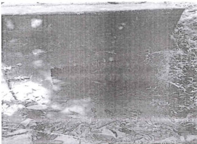
Foto 19: Alcantarilla de concreto, en buena condición Prog. 1+540
