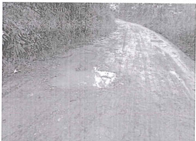
Foto 224: El tramo evaluado desde la prog. 4+400 a la prog. 4+490, presenta daños de tipo Baches , encontrándose 8, los cuales son de nivel de gravedad: 2.
