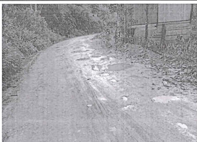
Foto 209: El tramo evaluado desde la prog. 2+440 a la prog. 2+470, presenta daños en la calzada de tipo Baches, de nivel de gravedad: 2.
