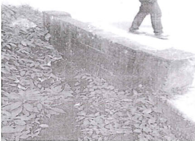
foto 45: Alcantarilla de concreto, obstruido por la malesas pero en buena condición Prog. 3+440
