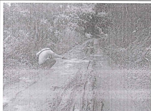
Foto 262: El tramo evaluado desde la prog. 11+120 a la prog. 11+170, presenta daños de tipo Baches , encontrándose 9, los cuales son de nivel de gravedad: 2.
