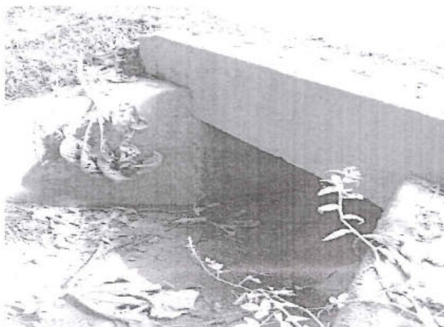
Foto 79: Alcantarilla de concreto, en buena condición Prog. 5+850
