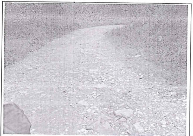
Foto 194: El tramo evaluado desde la prog. 0+520 a la prog. 0+720, presenta daños en la calzada de tipo Erosion , de nivel de gravedad: 2, alcanzando 1.80 m. de ancho de deterioro.
