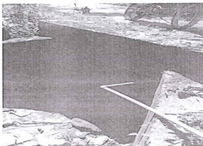
Foto 129: Alcantarilla de concreto, en buena condición Prog. 11+400
