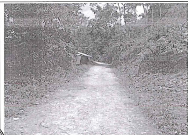
Foto 247: El tramo evaluado desde la prog. 8+530 a la prog. 8+750, presenta daños de tipo Erosion , los cuales son de nivel de gravedad: 1. alcanzando 2.1m de ancho de deterioro
