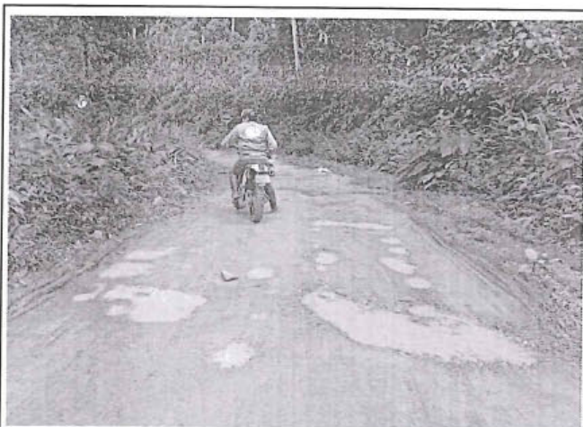
Foto 235: El tramo evaluado desde la prog. 6+410 a la prog. 6+453, presenta daños de tipo Baches , encontrandose 10, los cuales son de nivel de gravedad: 2.
