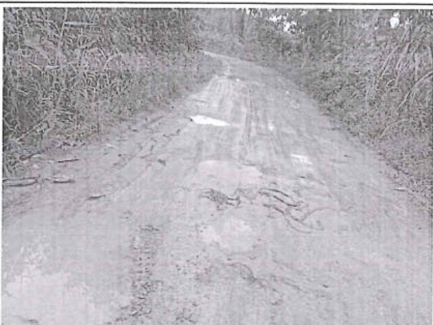
Foto 223: El tramo evaluado desde la prog. 4+300 a la prog. 4+380, presenta daños en la calzada de tipo Baches, de nivel de gravedad: 2.
