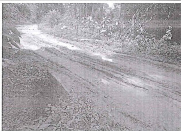
Foto 259: El tramo evaluado desde la prog. 10+620 a la prog. 10+720, presenta daños en la calzada de tipo Deformación , de nivel de gravedad: 2, alcanzando 2.50 m. de ancho de deterioro.
