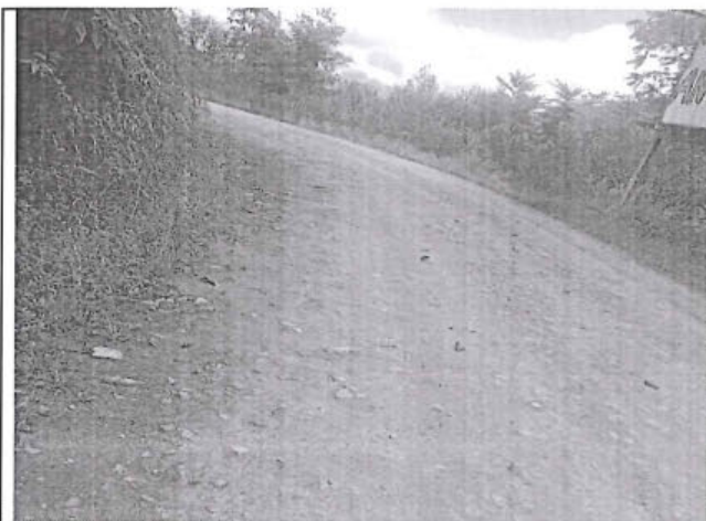
Foto 215: El tramo evaluado desde la prog. 3+060 a la prog. 3+280, presenta daños en la calzada de tipo Erosion, de nivel de gravedad: 1, alcanzando 1.00 m. de ancho de deterioro.
