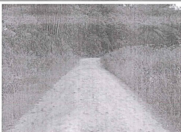
Foto 284: El tramo evaluado desde la prog. 5+810 a la prog. 5+990, presenta daños de tipo Erosion, los cuales son de nivel de gravedad: 1. alcanzando 2m de ancho de deterioro.
