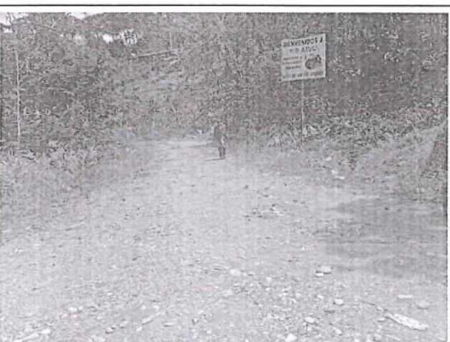
Foto 274: El tramo evaluado desde la prog. 12+940 a la prog. 12+990, presenta daños de tipo Erosion , los cuales son de nivel de gravedad: 1. alcanzando 2.1m de ancho de deterioro
