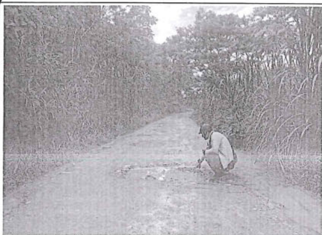
Foto 225: El tramo evaluado desde la prog. 4+520 a la prog. 4+600, presenta daños en la calzada de tipo Baches, de nivel de gravedad: 2.
