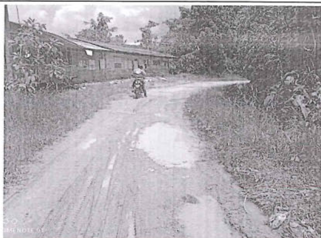
Foto 254: El tramo evaluado desde la prog. 10+070 a la prog. 10+100, presenta daños de tipo Baches , encontrándose 7, los cuales son de nivel de gravedad: 2.
