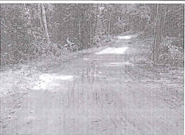
Foto 255: El tramo evaluado desde la prog. 10+130 a la prog. 10+170, presenta daños de tipo Baches , encontrándose 8, los cuales son de nivel de gravedad: 2.
