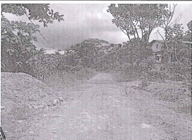
Foto 253: El tramo evaluado desde la prog. 9+960 a la prog. 9+995, presenta daños de tipo Baches , encontrándose 9, los cuales son de nivel de gravedad: 2.
