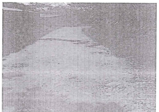
Foto 120: Superficie de Rodadura de afirmado, en estado de transitabilidad bueno prog. 10+500.
