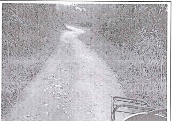
Foto 280: El tramo evaluado desde la prog. 4+760 a la prog. 4+990, presenta daños de tipo Erosion , los cuales son de nivel de gravedad: 1. alcanzando 1.6m de ancho de deterioro.
