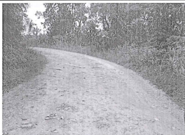
Foto 281: El tramo evaluado desde la prog. 5+020 a la prog. 5+280, presenta daños de tipo Erosion, los cuales son de nivel de gravedad: 1. alcanzando 1.9m de ancho de deterioro.
