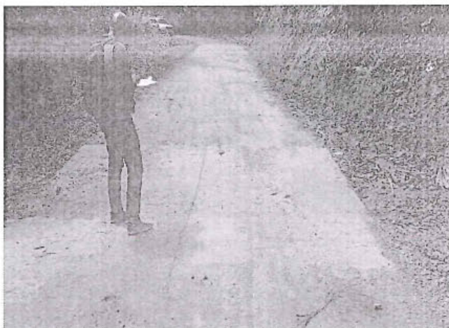
Foto 15: Baden en la prog. 1+355 con superficie de rodadura con afirmado y estado de transitabilidad bueno.
