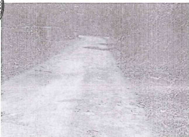
Foto 83: Superficie de Rodadura de afirmado, en estado de transitabilidad bueno prog. 6+500.
