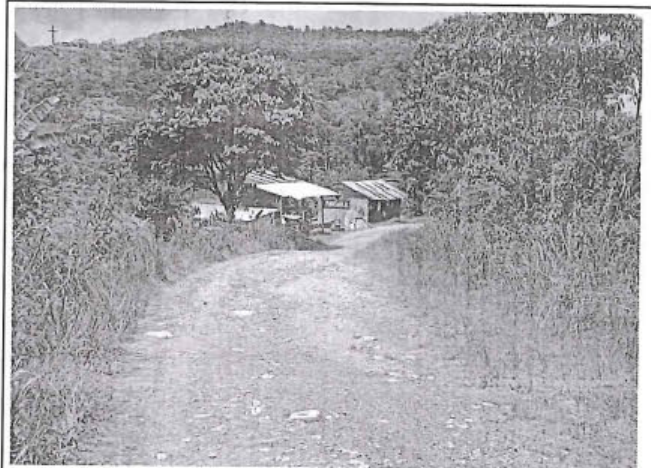
Foto 288: El tramo evaluado desde la prog. 6+740 a la prog. 6+ 950, presenta daños de tipo Erosion, los cuales son de nivel de gravedad: 1. alcanzando 2.1m de ancho de deterioro.
