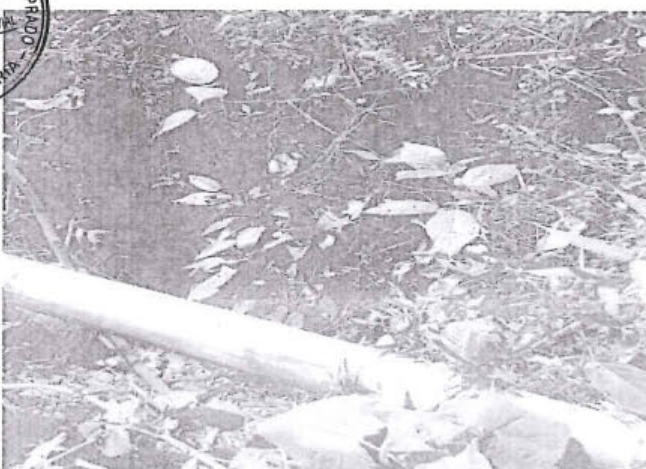
Foto 89: Alcantarilla Artesanal, obstruido por la maleza pero en buena condición Prog. 7+250
