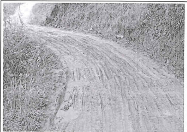
Foto 276: El tramo evaluado desde la prog. 4+080 a la prog. 4+110, presenta daños en la calzada de tipo Deformacion , de nivel de gravedad: 2, alcanzando 2.80 m. de ancho de deterioro.
