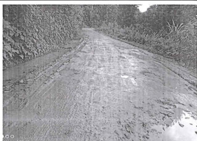
Foto 210: El tramo evaluado desde la prog. 2+520 a la prog. 2+580, presenta daños en la calzada de tipo Baches, de nivel de gravedad: 2.
