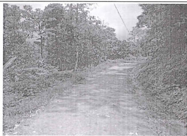
Foto 251: El tramo evaluado desde la prog. 9+530 a la prog. 9+780, presenta daños de tipo Erosion , los cuales son de nivel de gravedad: 1. alcanzando 1.7m de ancho de deterioro
