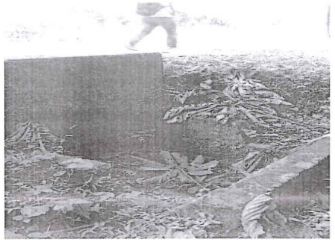
Foto 20: Alcantarilla de concreto, obstruido pero en buena condición Prog. 1+720
