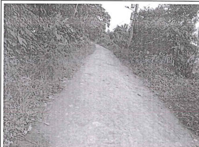
Foto 242: El tramo evaluado desde la prog. 7+760 a la prog. 7+920, presenta daños de tipo Erosion, los cuales son de nivel de gravedad: 1. alcanzando 1.8m de ancho de deterioro.
