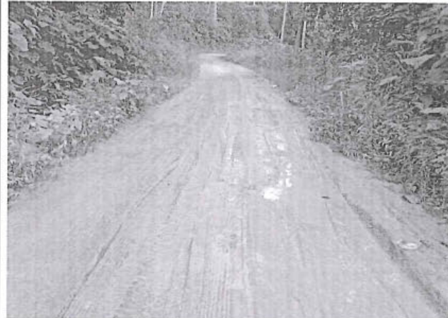
Foto 240: El tramo evaluado desde la prog. 7+420 a la prog. 7+490, presenta daños en la calzada de tipo Deformacion, de nivel de gravedad: 1, alcanzando 2.50 m. de ancho de deterioro.
