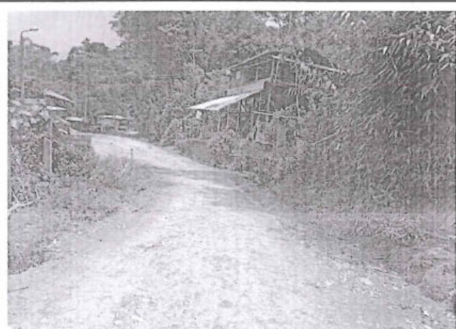
Foto 250: El tramo evaluado desde la prog. 9+270 a la prog. 9+490, presenta daños de tipo Erosion , los cuales son de nivel de gravedad: 1. alcanzando 1.8m de ancho de deterioro
