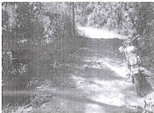
Foto 110: Superficie de Rodadura de afirmado, en estado de transitabilidad regular prog. 9+500.
