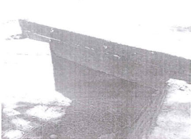
Foto 88: Alcantarilla de concreto, en buena condición Prog. 7+120
