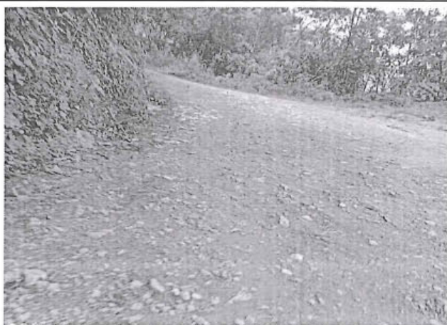
Foto 203: El tramo evaluado desde la prog. 1+620 a la prog. 1+790, presenta daños en la calzada de tipo Erosión , de nivel de gravedad: 1, alcanzando 1.70 m. de ancho de deterioro.
