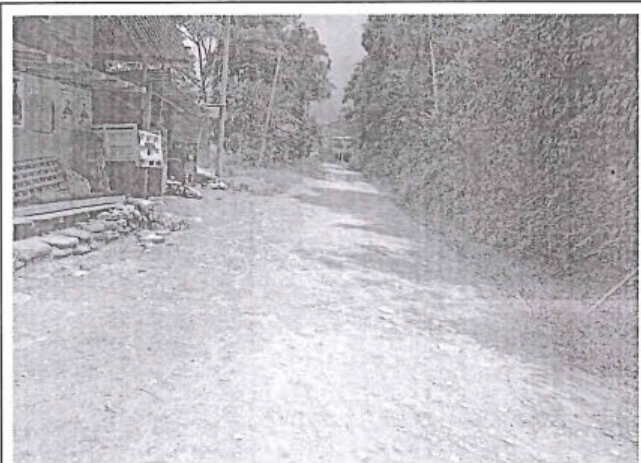
Foto 249: El tramo evaluado desde la prog. 9+040 a la prog. 9+250, presenta daños de tipo Erosion , los cuales son de nivel de gravedad: 1. alcanzando 1.9m de ancho de deterioro
