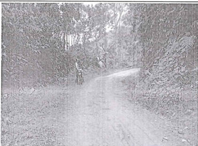
Foto 231: El tramo evaluado desde la prog. 5+670 a la prog. 5+845, presenta daños de tipo Erosion , nivel de gravedad 1 , alcanzando 1.7m de ancho de deterioro.
