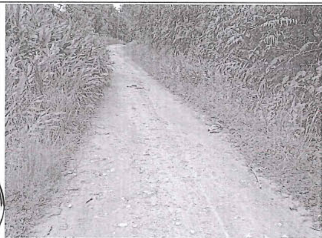
Foto 277: El tramo evaluado desde la prog. 4+140 a la prog. 4+350, presenta daños en la calzada de tipo Erosion , de nivel de gravedad: 1, alcanzando 1.80 m. de ancho de deterioro.
