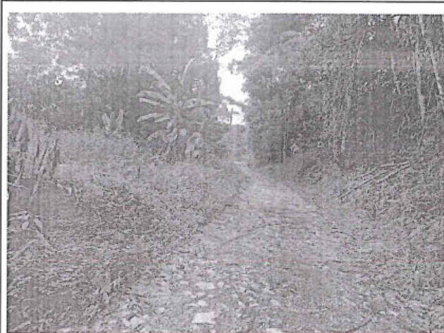
Foto 260: El tramo evaluado desde la prog. 10+750 a la prog. 10+990, presenta daños de tipo Erosion , los cuales son de nivel de gravedad: 2. alcanzando 2.1m de ancho de deterioro
