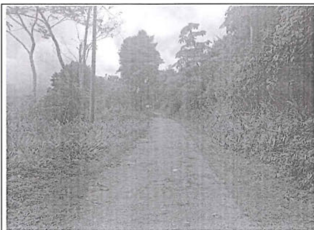
Foto 269: El tramo evaluado desde la prog. 12+210 a la prog. 12+460, presenta daños de tipo Erosion , los cuales son de nivel de gravedad: 1. alcanzando 1.9m de ancho de deterioro
