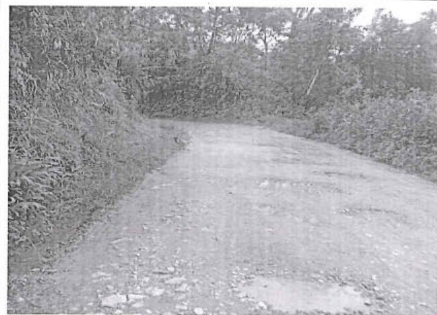
Foto 222: El tramo evaluado desde la prog. 4+180 a la prog. 4+280, presenta daños de tipo Baches , encontrándose 8, los cuales son de nivel de gravedad: 2.
