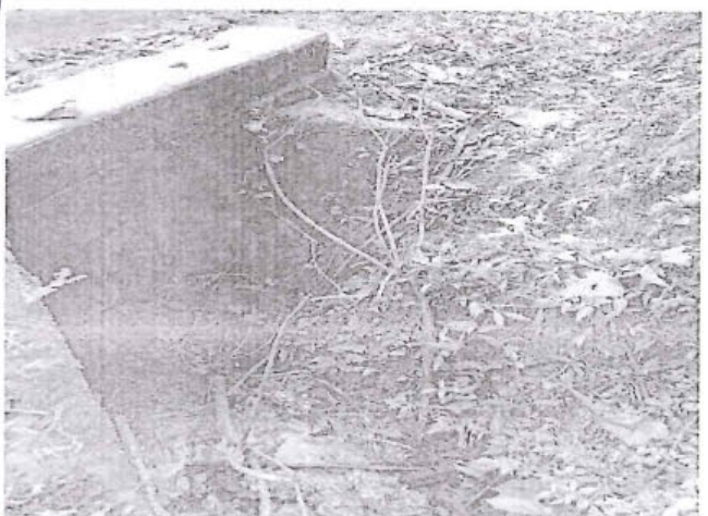
Foto 72: Alcantarilla de concreto, en buena condición Prog. 5+360
