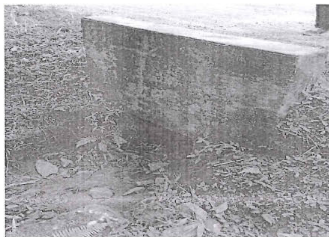
foto 38: Alcantarilla de concreto, en buena condición Prog. 3+020
