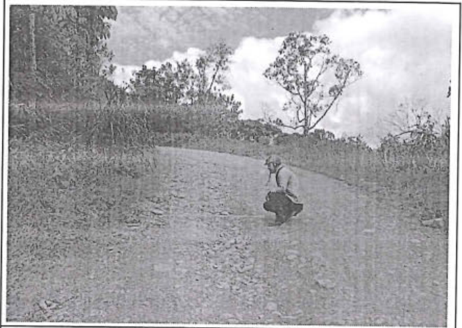
Foto 192: El tramo evaluado desde la prog. 0+300 a la prog. 0+460, presenta daños en la calzada de tipo Erosión , de nivel de gravedad: 2, alcanzando 1.10 m. de ancho de deterioro.
