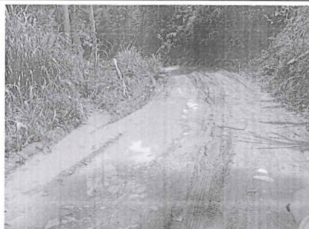
Foto 258: El tramo evaluado desde la prog. 10+520 a la prog. 10+590, presenta daños de tipo Baches , encontrándose 11, los cuales son de nivel de gravedad: 2.
