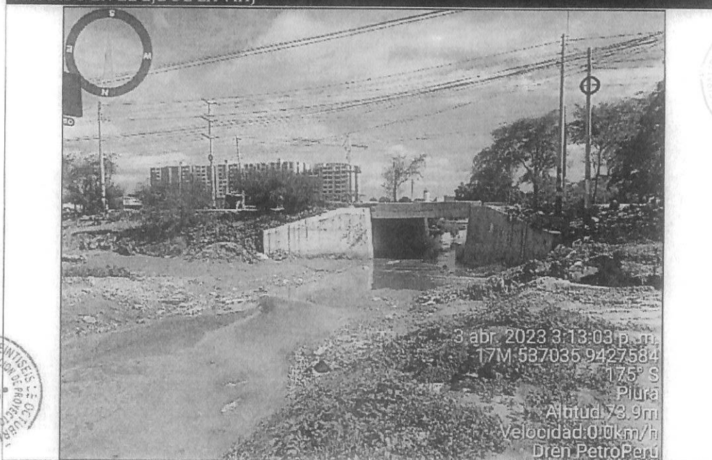
IMAGEN N°06: MOVILIDAD URBANA DETERIORADA PARTE LATERAL DEL LOCAL PETROPERÚ ENTRE AV. SÁNCHEZ CERRO Y ESPALDAS DEL LOCAL PETROPERÚ, PROYECCIÓN DE COLECTOR PETRO PERU (CELDA SUBTERRANEAS DE CONCRETO ARMADO EN EL EJE DE LA VÍA)
