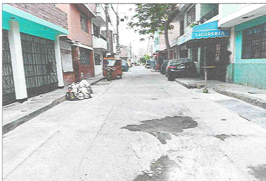
Fotografía N° 2: Calle Río Majes, en esta última presenta fallas estructurales severas en la carpeta de rodadura, perjudicando el tránsito normal de los vecinos y conductores.
