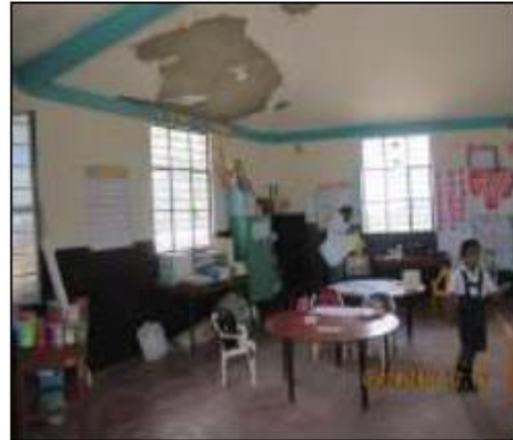
Fotos N° 34, 35: Se observa la parte frontal y el interior del aula de 1er grado. Techo resanado, piso de cemento. No cuenta con sistema de drenaje pluvial.
