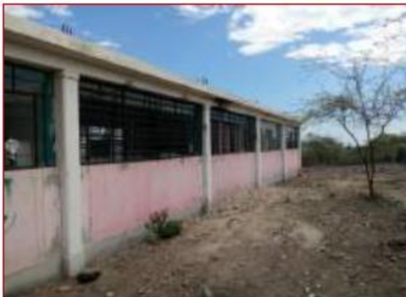
Fotos N° 52, 53 : En vistas se observa parte posterior y lateral del pabellón 4.No cuenta con veredas, lo que la cimentación queda al descubierto.
