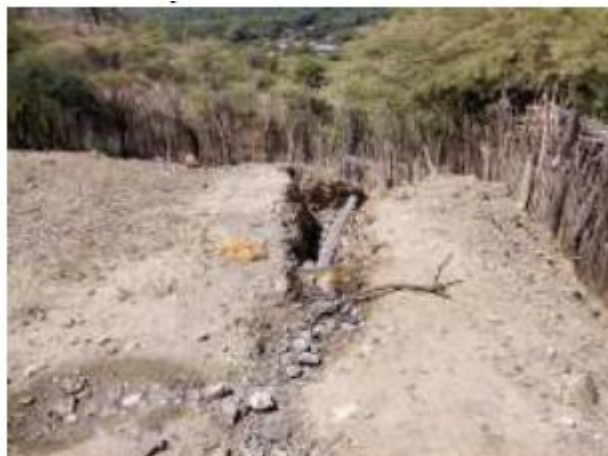
Foto N° 26: Se observa la tubería donde se expulsa lo de los servicios higiénicos a la intemperie.
