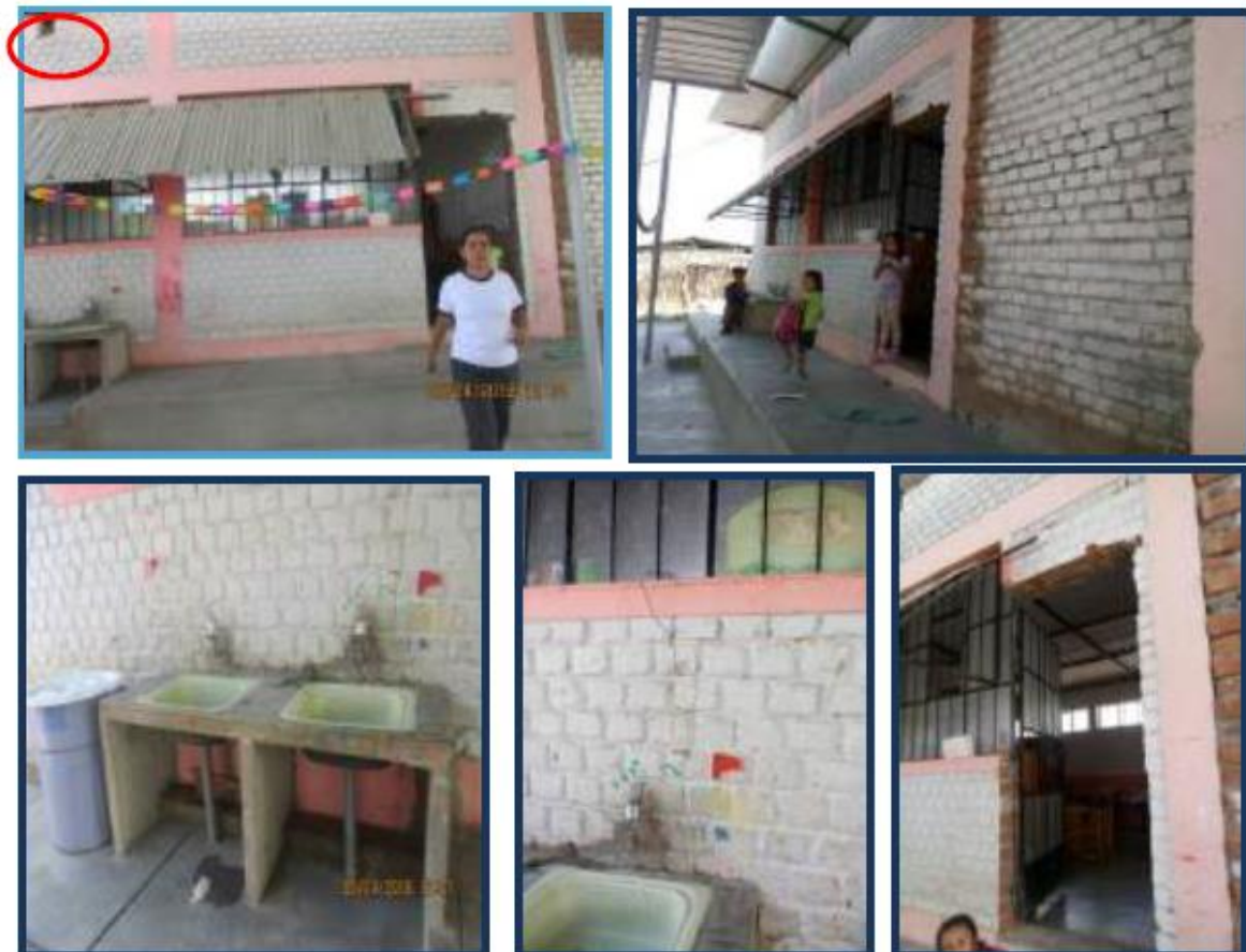
Fotos N°7,8,9,10,11: En vistas, se observa parte frontal del aula de 4 y 5 años. Presenta rajaduras en la pared frontal, donde han construido 02 lavaderos. Se observa que las ventanas han sido cubiertas con calamina debido al fuerte sol que les llega a los niños, provocando baja luminosidad y a la vez genera mucho calor a los niños.
