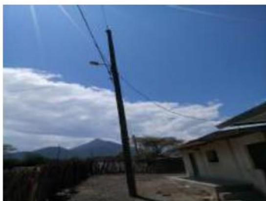
Foto N°27: En vista, se observa un poste de energía eléctrica dentro del área de la I.E. representando un peligro para los niños.
