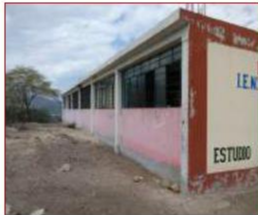
Fotos N° 52, 53 : En vistas se observa parte posterior y lateral del pabellón 4.No cuenta con veredas, lo que la cimentación queda al descubierto.
