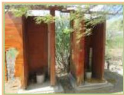
Foto N°71 : En vistas ,se observa el mal de estado de conservación de las letrinas. Ya colapsaron.
