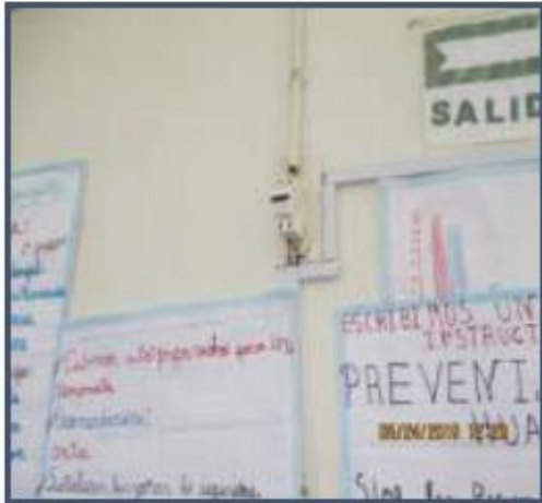
Fotos N°48,49: Se observa caja de energía expuesta al interior del aula, representando un peligro para los niños.
