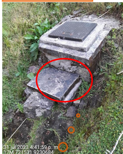
Captación existente, en mal estado y tubería expuesta
