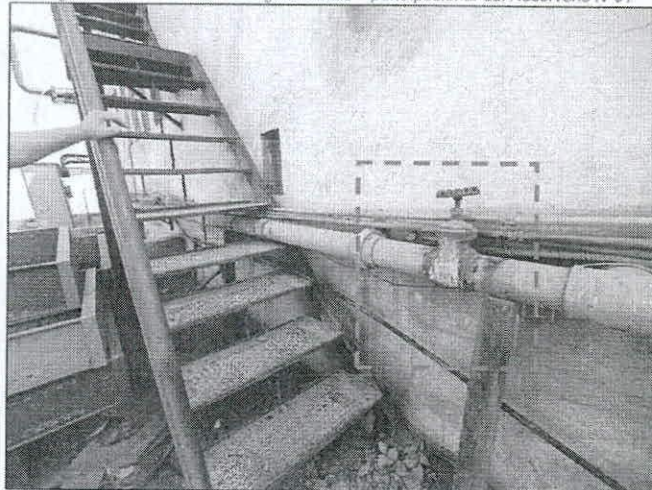
Imagen N°02: Tubería de hierro galvanizado – parte posterior del Reservorio N°01
