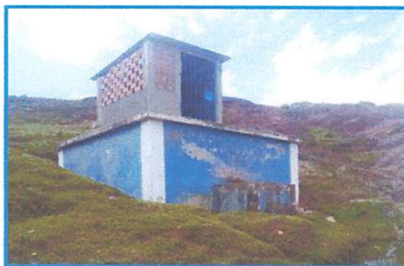
Foto 03: Muestra el reservorio de Shuypillay Alto, se puede observar la caseta de válvulas deteriorado y el sistema de cloración inconcluso
