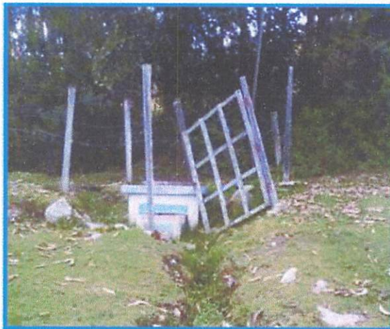
Foto 01: Muestra una de captaciones de Shuypillay Alto, con cercos de madera y alambre de púas deteriorado
