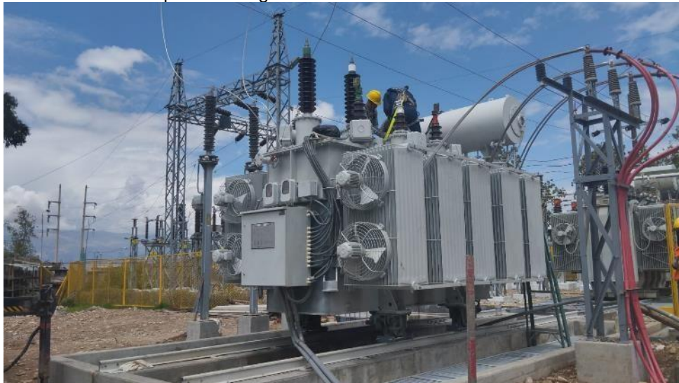
Figura N°01: Transformador de Potencia de 15/20 MVA Subestación Eléctrica Salesianos
