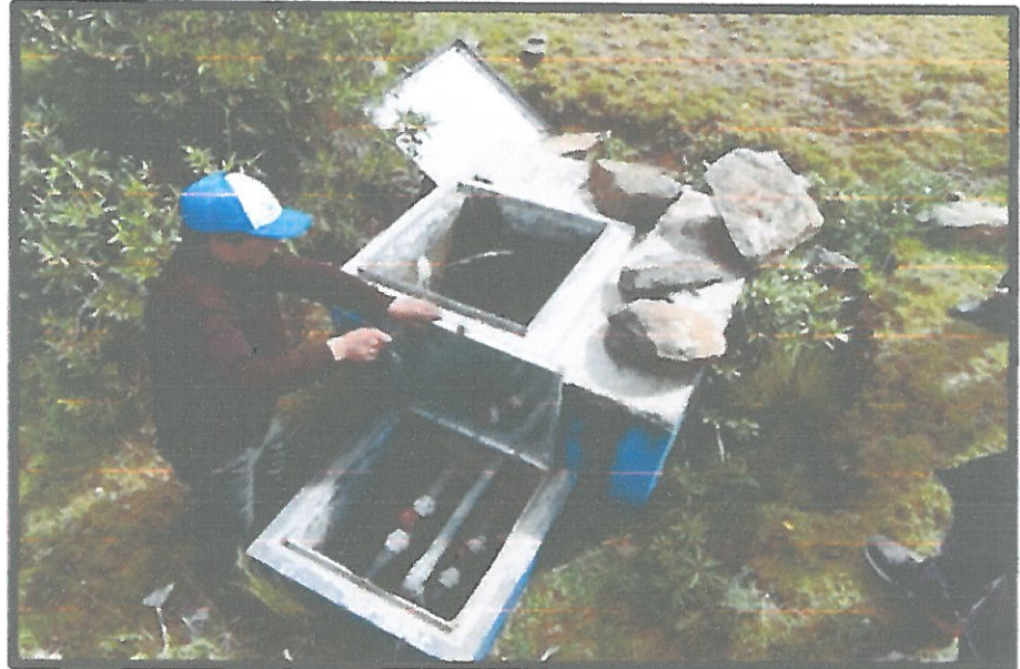
FOTOGRAFIA N° 02 CAJA DE VÁLVULAS DE LA CÁMARA DE REUNIÓN
