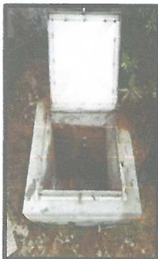
FOTOGRAFIA N° 01 CÁMARA HÚMEDA CAPTACION DE MANANTIAL ISHTANQUI 01
