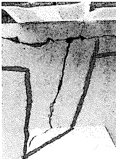
Foto N° 04: Vista de grietas en diagonal en el pabellón 03
