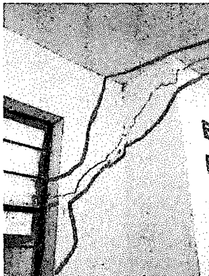
Foto N° 04: Vista de grietas en diagonal en el pabellón 03
