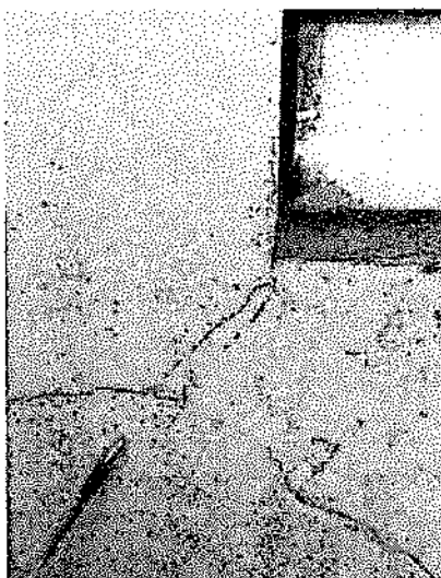
Foto N° 01: Grietas diagonales en vanos de ventanas en el pabellón 03
