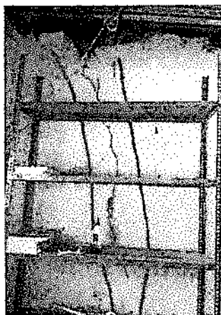
Foto N° 03: Grietas en el cielo raso en el pabellón 03
